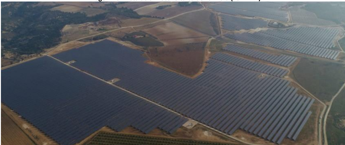
Imagen 19: Instalación fotovoltaica de La Mula (494 MW)
