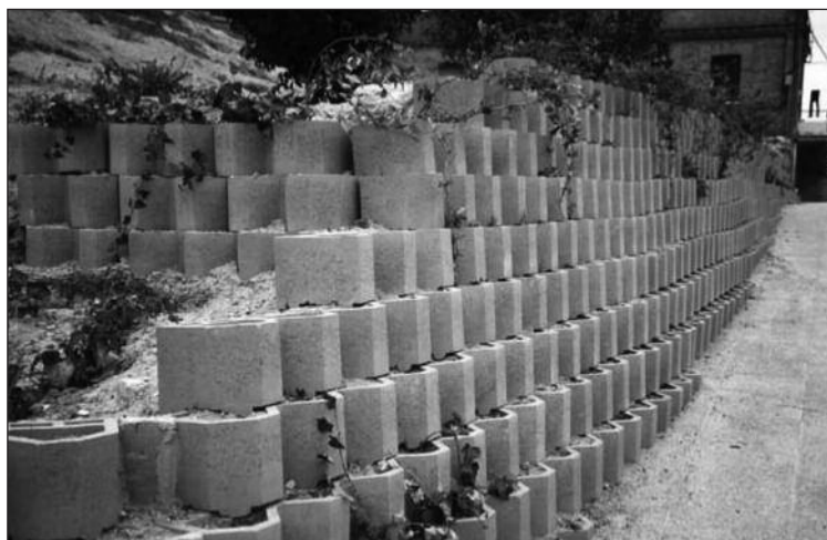
Figura 9.10. Muro de bloques ou xardineiras en Cristo del Otero (Palencia) (foto: J. Navarro)
