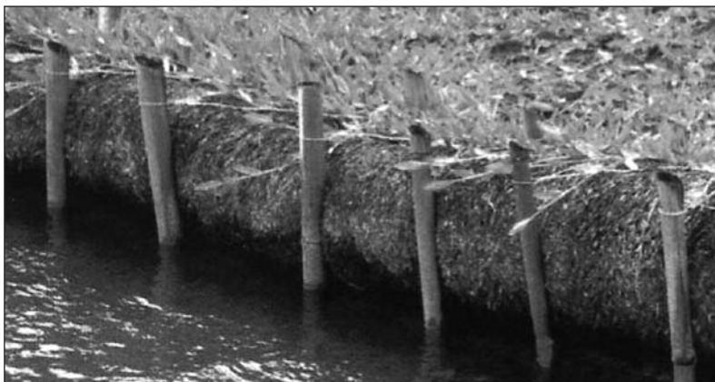
Figura 9.2. Biorolos de coco ao borde dun río en Brasil (Fonte: deflor Bioengenharia, 2002)
