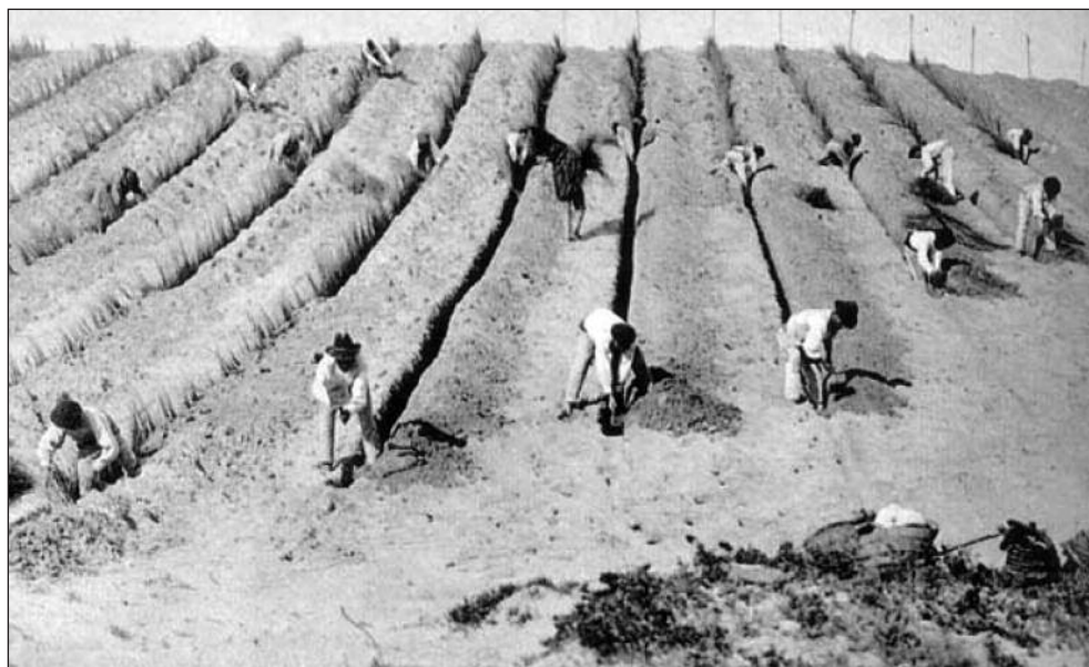
Figura 9.1. Fixación de dunas en Guardamar de Segura (Alacante) mediante cordóns de ramaxe a principios do século XX (Fonte: Ministerio de Fomento, 1998)
