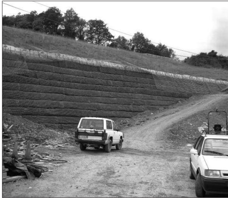
Figura 9.11. Muro de terra reforzada recentemente construído na Autovía A-68 en Llera (Asturias) (foto: A. Sáiz)
