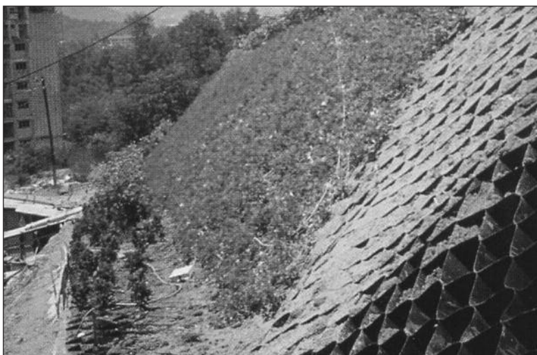
Figura 9.5. Revexetación e estabilización de ladeiras mediante xeoceldas (Fonte: Presto, 2000)
