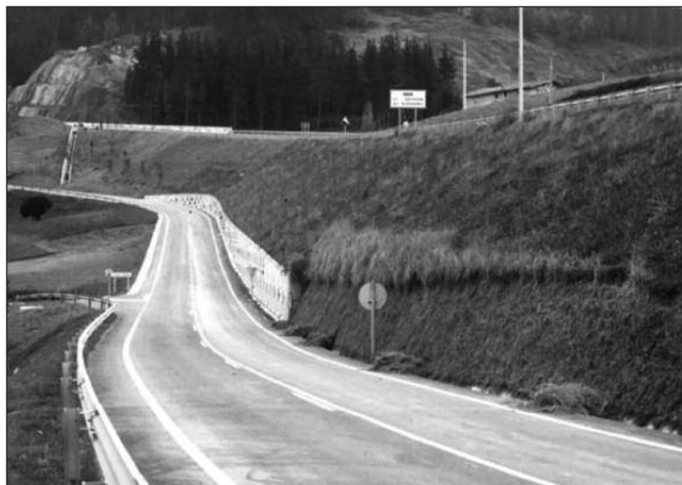
Figura 9.12. Aspecto dun muro de terra reforzada no País Vasco (zona do sinal de tráfico) tras unha sega de mantemento (foto: J. Navarro)
