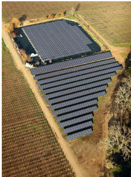
Figura 12. Instalación en la bodega Far Niente. Fuente: [6]
