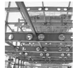
Estructura metálica aligerada
