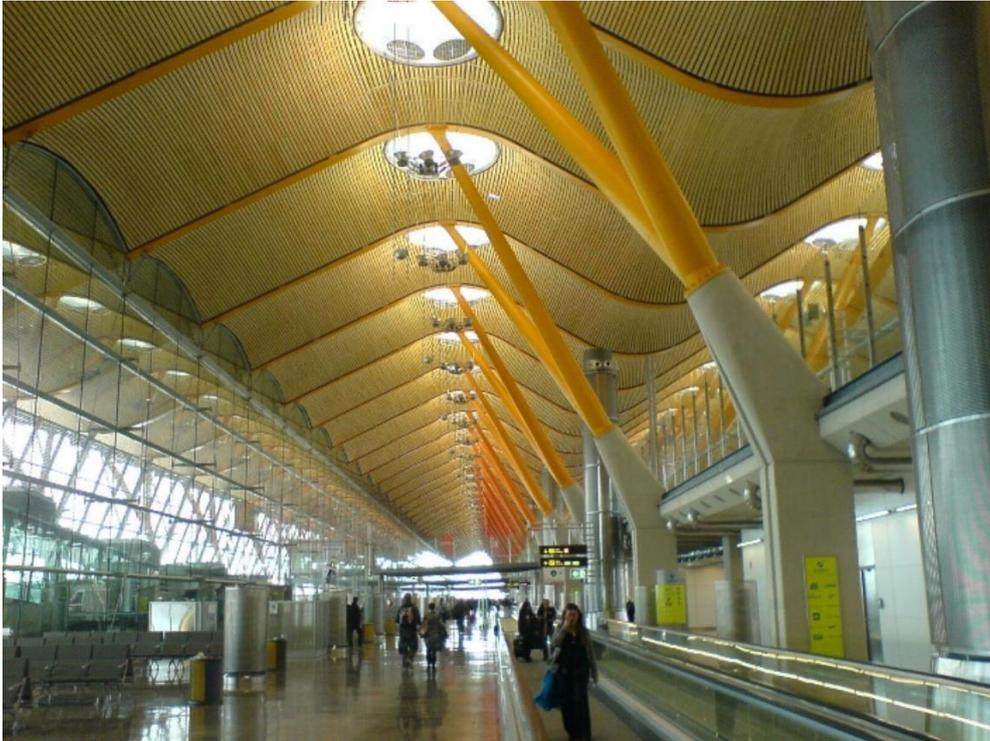
*Ilustración 13 Integración de los conductos de impulsión de aire en la estructura (Aeropuerto de Barajas) (Wikimedia Commons. (12 de febrero de 2006). Terminal 4 del Aeropuerto de Madrid-Barajas. Rogers-Lamela,2004 [Fotografía]. Wikimedia Commons. [https://commons.wikimedia.org/wiki/File:Barajas\\_T4\\_03.JPG](https://commons.wikimedia.org/wiki/File:Barajas_T4_03.JPG))*
