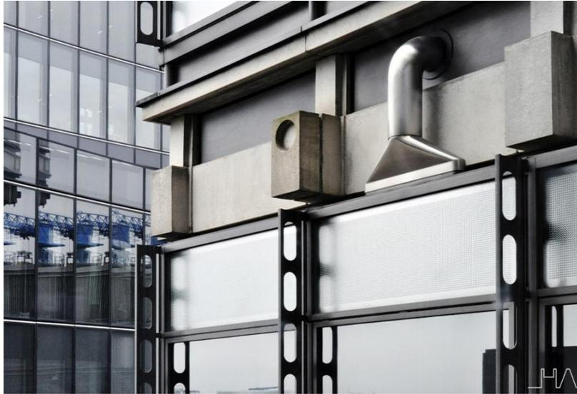
*Ilustración 55 Detalle del sistema de climatización por la fachada (Ariza, H. (24 de octubre de 2014). LLOYD'S BUILDING. Diseño futurista en la City de Londres [Fotografía]. Architectural Visits. <https://architecturalvisits.com/lloyds-building-lloyds-of-london/>)*
