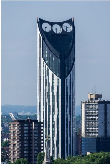
*Ilustración 26 Ejemplo de edificio en altura con aerogeneradores (Strata SE1) (Wikimedia Commons. (31 de mayo de 2014). Strata SE1 from Monument 2014 [Fotografía]. Wikimedia Commons. [https://commons.wikimedia.org/wiki/File:Strata\\_SE1\\_from\\_Monument\\_2014.jpg](https://commons.wikimedia.org/wiki/File:Strata_SE1_from_Monument_2014.jpg))*
