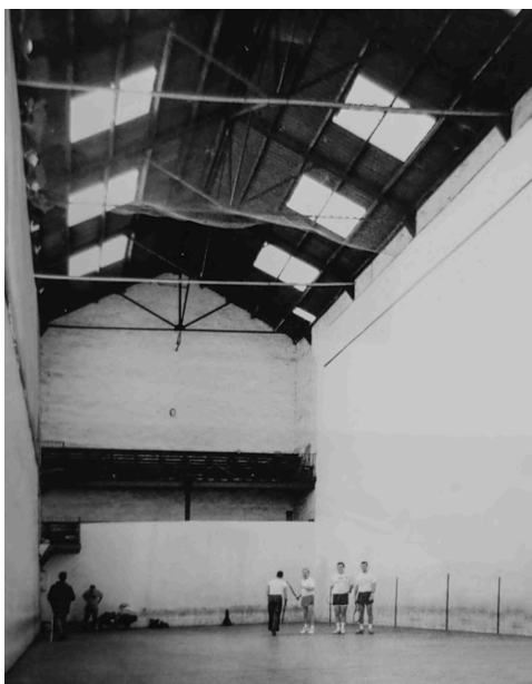
Fig. 45. Fronto Cubierto de la calle Expósitos. 1994. Fuente: AVa
