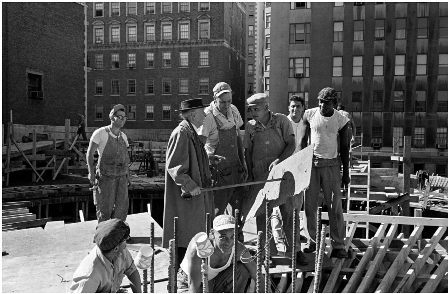
Fig 26. Frank Lloyd Wright inspecciona la construcción del Museo Guggenheim en Nueva York. 1957.
