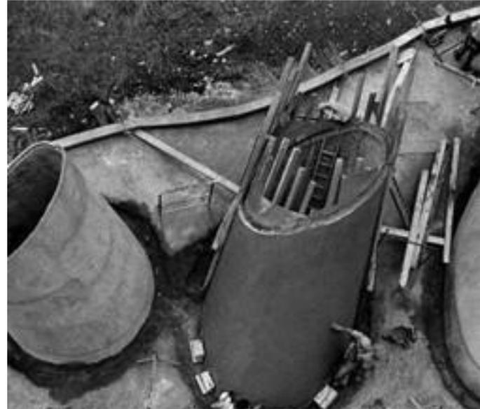
Fig. 8 Encofrado y hormigonado de los pozos de luz de la Tourette
