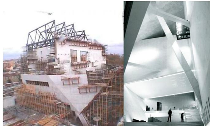
*Fig. 19 Casa da música. Construcción del cascarón e influencia de la estructura en el interior*
