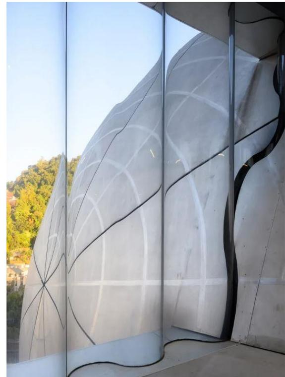
Fig. 24 Encuentro "desnudo" entre el vidrio ondulado y la esfera metálica de Taipéi
