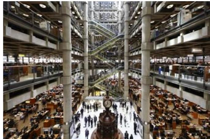
*Fig. 13 Interior del Lloyd's Building. Elementos prefabricados como pilares y losas*
