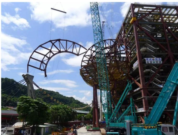
Fig. 46 Montaje de las cerchas en obra
