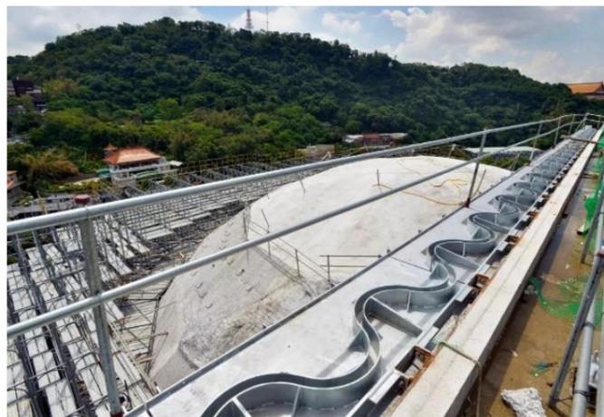
Fig. 52 Detalle del anclaje del vidrio ondulado en Taipéi.
