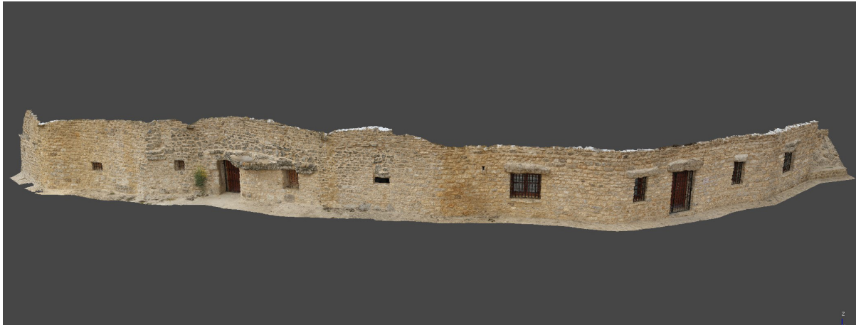
Figura 44. Levantamiento de la fachada rehabilitada. Resultado texturizado. Fuente: Elaboración propia
