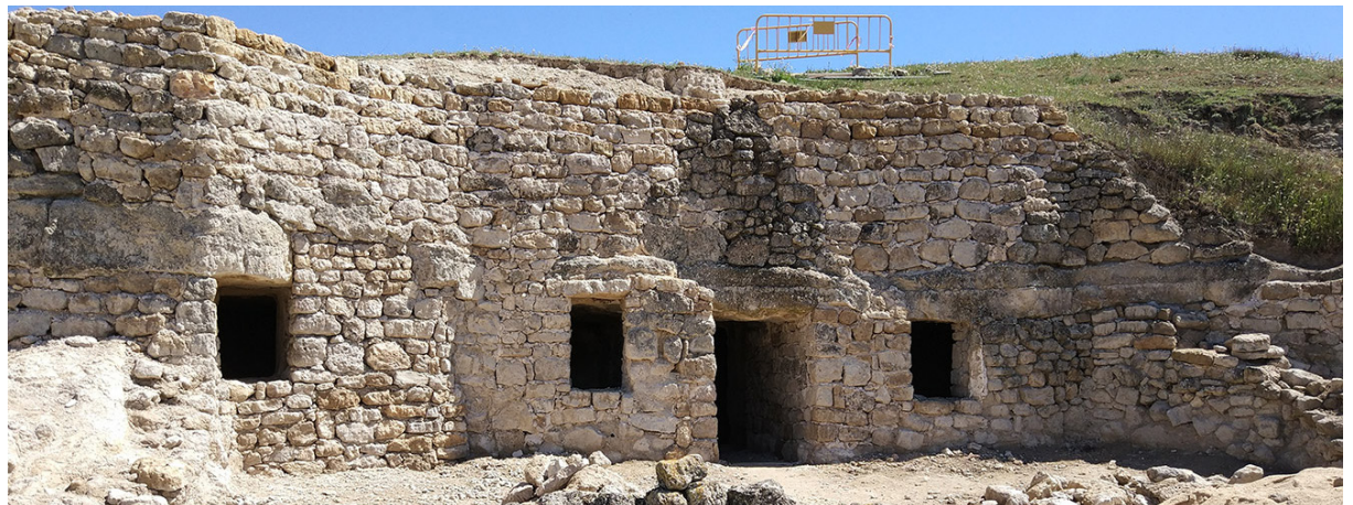
Figura 29. Estado actual de la fachada en obras. Fuente: Elaboración propia
