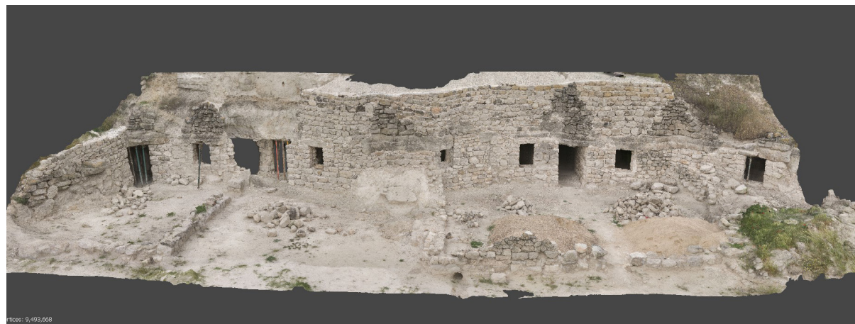
Figura 37. Levantamiento de la fachada en obras con los datos de Mayo. Resultado texturizado. Fuente: Elaboración propia
