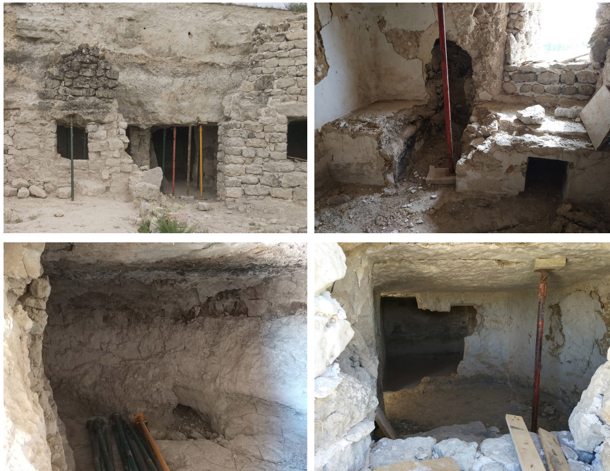
Figura 73. Estado actual del exterior e interior de las casas cueva en proceso de rehabilitación. Fuente: Elaboración propia
