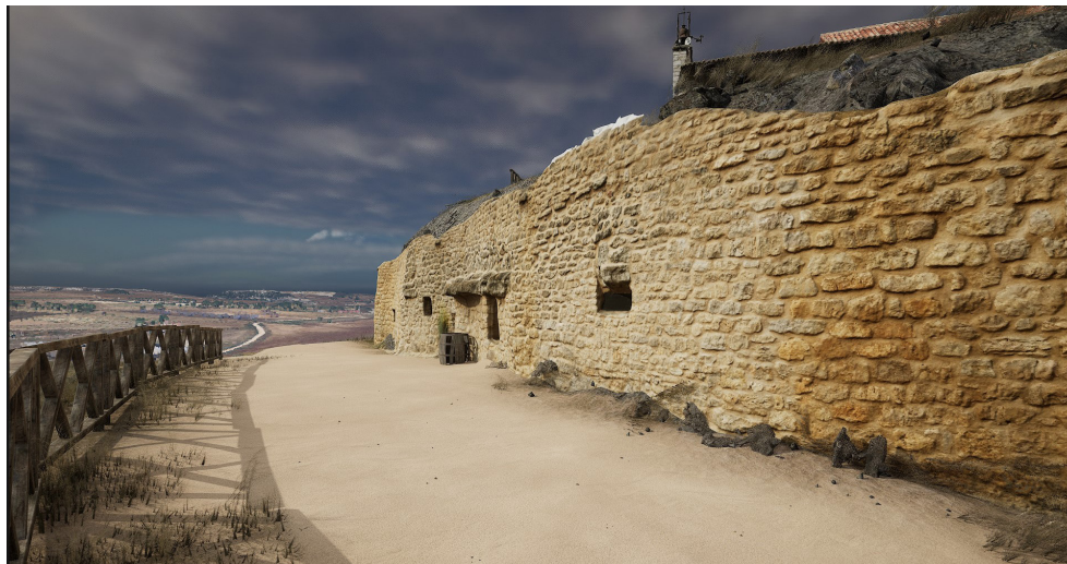
Figura 97. Vista por el camino junto a las casas rehabilitadas. Fuente: Elaboración propia
