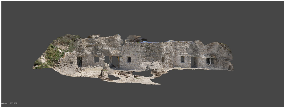
Figura 35. Levantamiento de la fachada en obras con los datos de Abril. Resultado texturizado. Fuente: Elaboración propia
