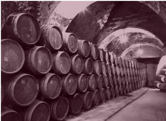
Fig 48. Fotografía de archivo de una de las galerías de la ampliación de la bodega de 1970. (Fuente: sitio web, https://www.bodegasprotos.com/es/ ).
