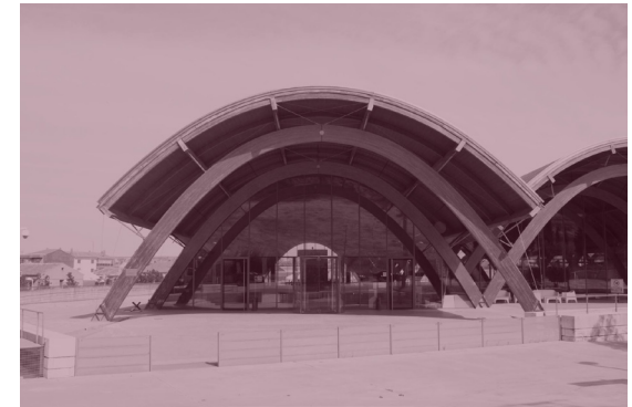
Fig 75. Fotografía de la cristalera de la entrada principal de la bodega de Protos. (Fuente: Elaboración propia).
