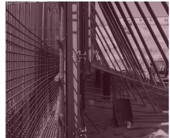
Fig 66. Fotografía en obra de la construcción de uno de los muros de sótano de la bodega Protos. (Fuente: Elaboración propia a partir de la documentación facilitada por Rosa Bellido Pla).
