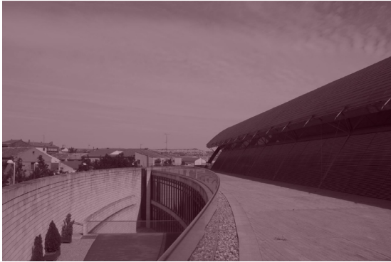
Fig 59. Fotografía del patio de la sección administrativa de la bodega Protos. (Fuente: Elaboración propia).
