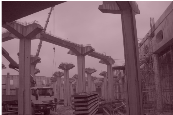
Fig 63. Fotografía en obra de la construcción de la zona subterránea de la bodega Protos. (Fuente: Elaboración propia a partir de la documentación facilitada por Rosa Bellido Pla).
