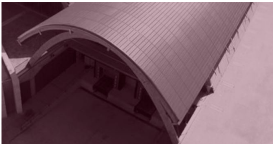
Fig 54. Fotografía del despiece de las tejas cerámicas de la cubierta de la bodega Protos. (Fuente: sitio web, https://www.bodegasprotos.com/es/ ).
