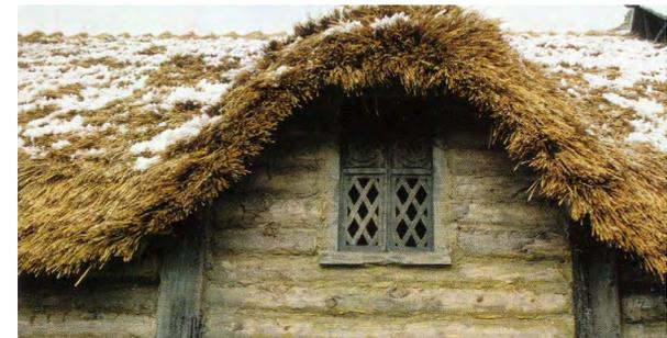
Fig. 168\_ Cubierta de paja en un edificio de Edoras.
