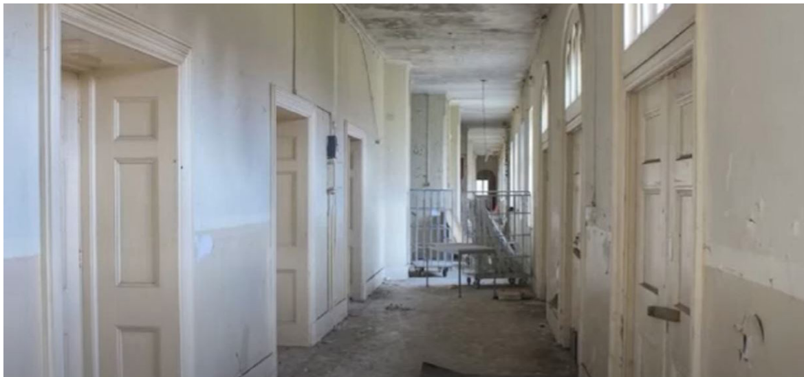
Fig. 63. Fotografía del estado actual del pasillo.
