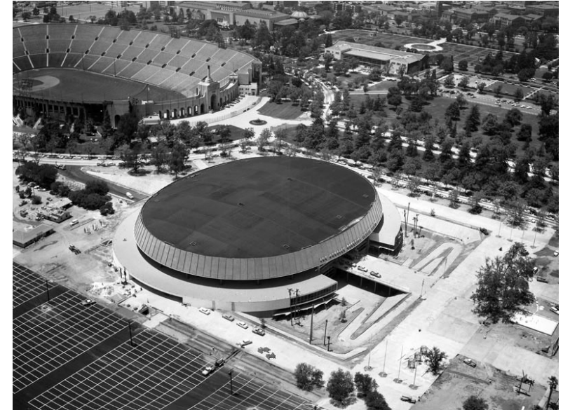
Fig. 25. Vista aerea del L.A Sports Arena
