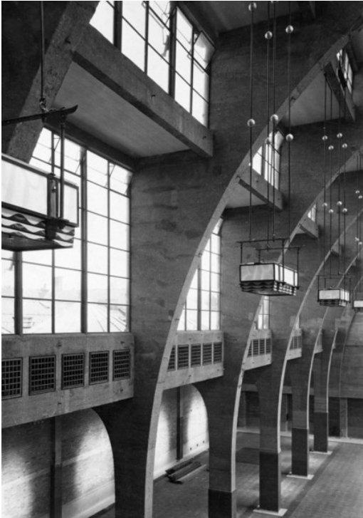
Fig. 29. Estructura parabólica del Lawrence Hall
