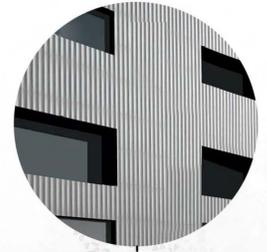
Envoltorio de fachada noreste se prevé conformado con Paneles CLT con aislamiento térmico (e:80mm), láminas de barrera de vapor y de impermeabilización con lámina de PVC intermedia y sobre CLT, estructura con rastreles de aluminio de fijación (30\*30/e:1,5 mm), y colocación de chapa de acero lacado y
