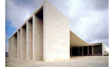
Pabellón de portugal de alvaro siza
