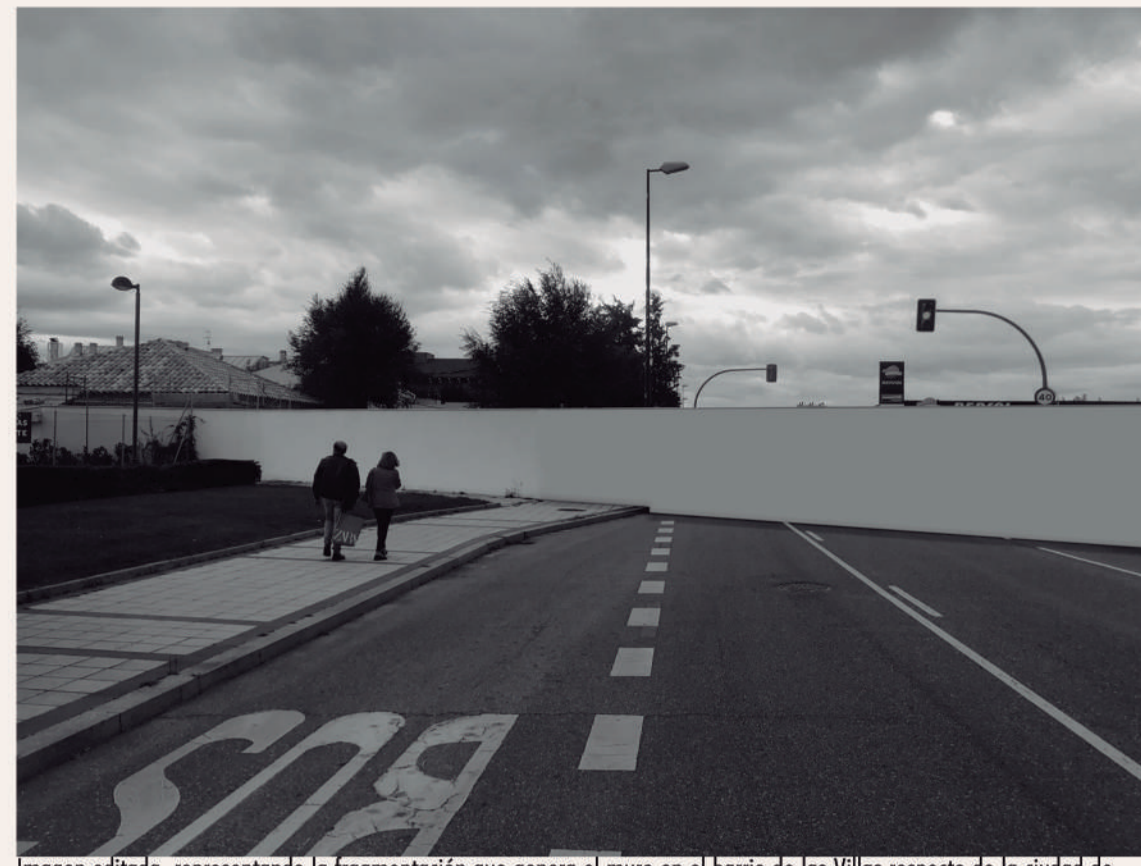
Imagen editada, representando la fragmentación que genera el muro en el barrio de las Villas respecto de la ciudad de Valladolid.
