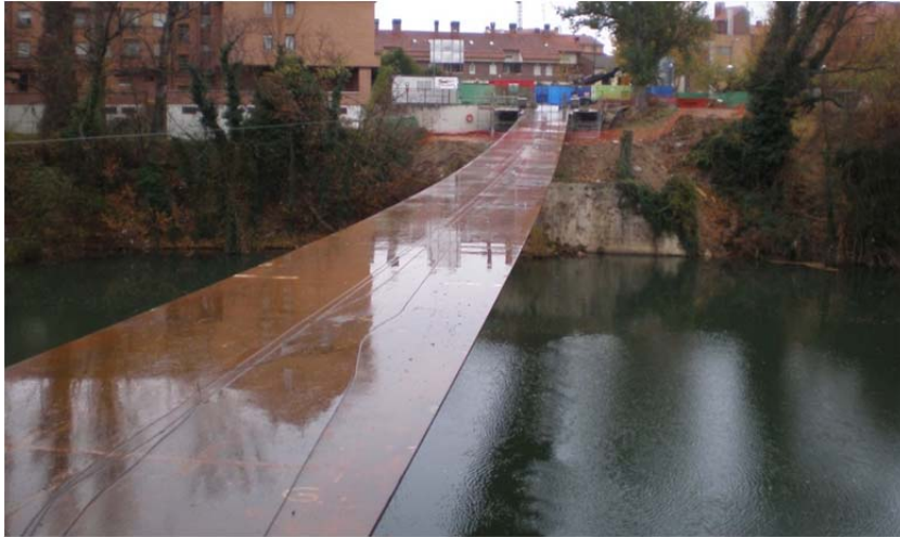
Figura 3-69. Pletina de acero de la PPGB.
