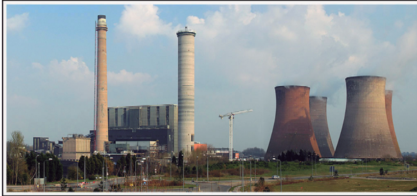
Fig. 1. Central térmica de Rugeley. Vieja chimenea a la izquierda y nueva chimenea en el centro.
