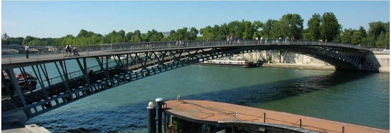
Figura 1-4. Pasarela Solferino de Paris.
