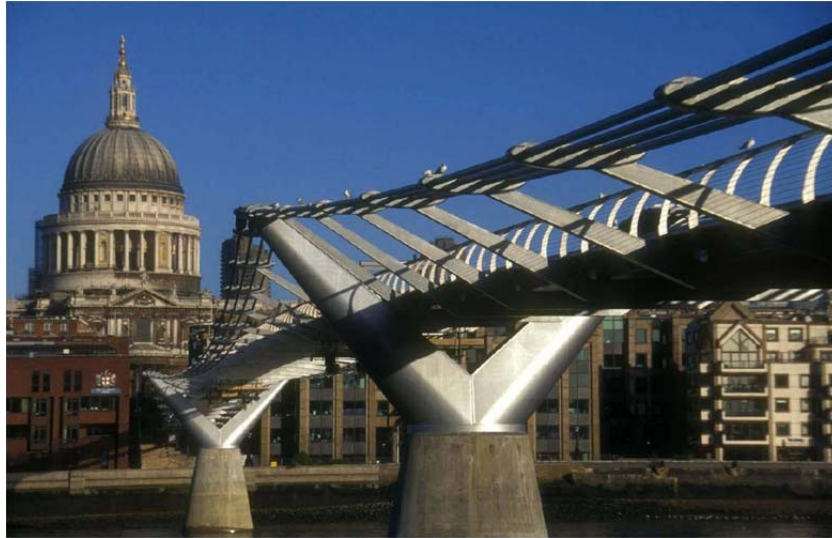
Figura 1-1. Pasarela "Millennium Bridge" de Londres [10].
