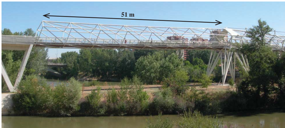
Fig. 2. Vano 2 de la pasarela.
