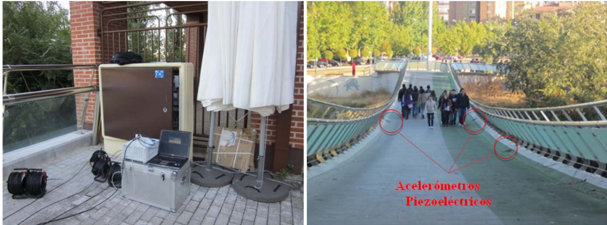
Figura 3-80. Sistema de medida de los acelerómetros piezoeléctricos y su posición en el tablero.
