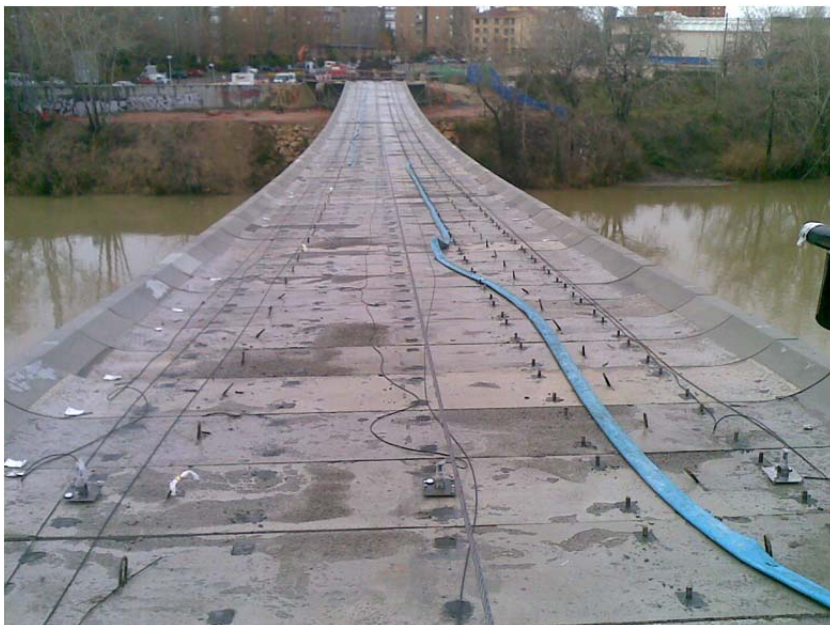
Figura 3-70. Colocación de las losas de hormigón en la PPGB
