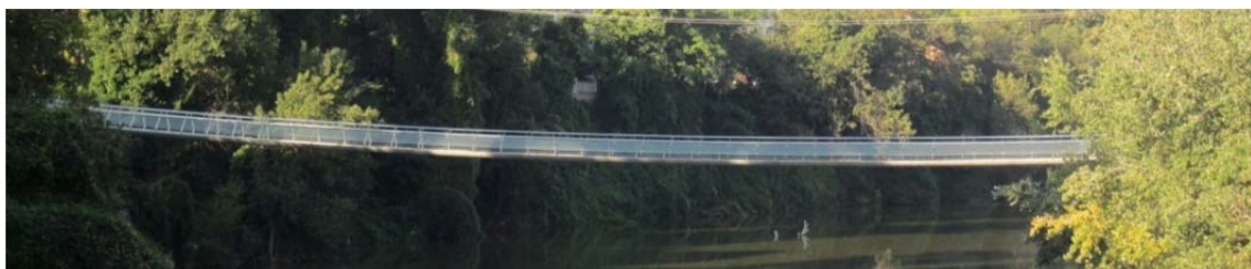
Figura 3-68. Pasarela Pedro Gómez Bosque. (a) Vista a la entrada de la pasarela. (b) Vista general.
