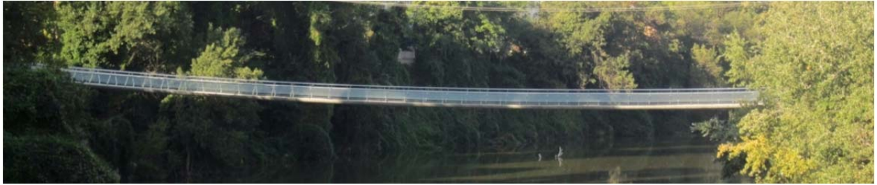
Figura 2-2. Vista general de la pasarela peatonal Pedro Gómez Bosque de Valladolid.
