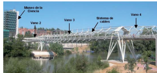
Fig. 3: Vista general de la PMC de Valladolid
