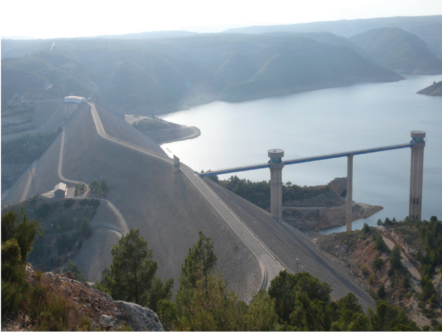
Figura 5. Presa de Tous, en el Júcar. Fuente: Fotografía del autor.
