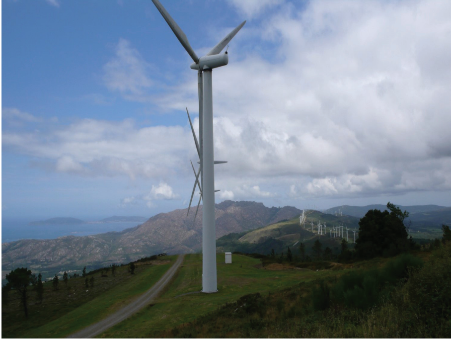
Figura 14. Parque eólico de Carnota en Galicia. Fuente: Fotografía del autor.
