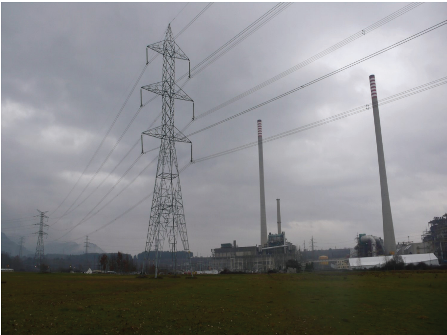
Figura 10. Central térmica de Compostilla, cerca de Ponferrada. Fuente: Fotografía del autor.
