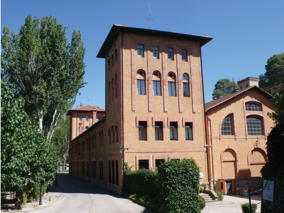
Figura 6. Central de Bolarque, en el Tago. Fuente: Fotografía del autor.
