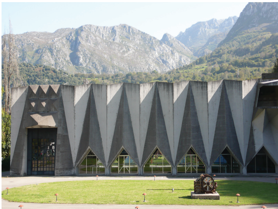
Figura 7. Central de Proaza, en Asturias. Fuente: Fotografía del autor.
