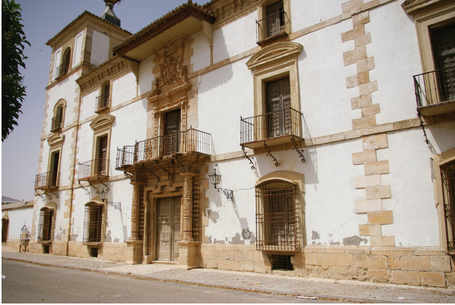
Figura 7. Casa-Palacio de las Torres, Tembleque. Fuente: Fotografía del autor.
