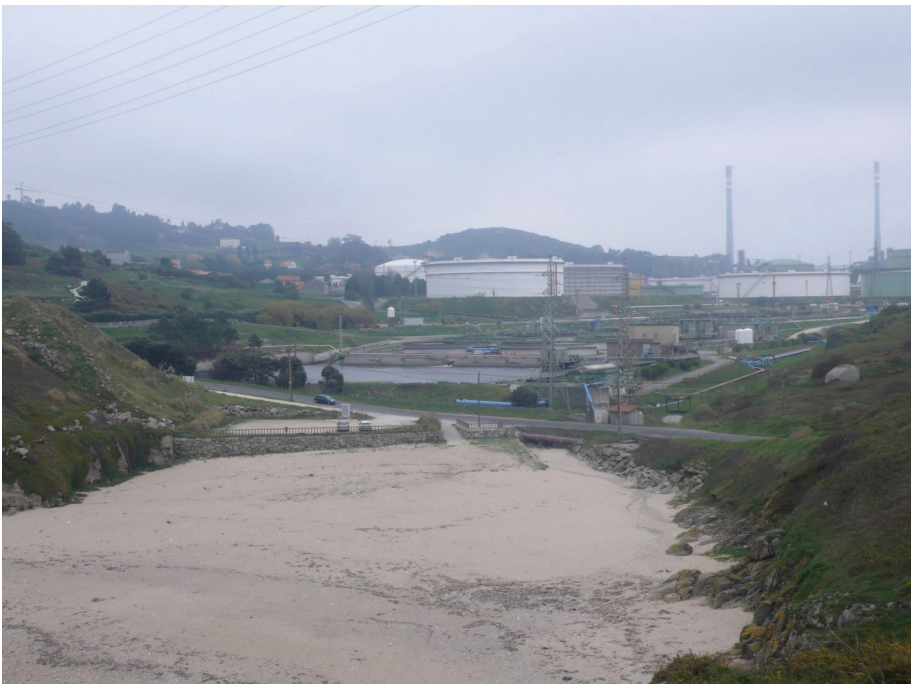
Figura 2. Refinería de petróleos de A Coruña, frente a la playa de Bens. Fuente: Fotografía del autor.
