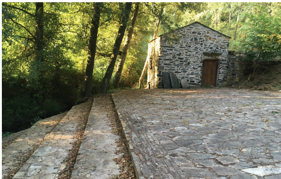
Figura 2. Urbanización del entorno del Molino de la Ribera (Alcorcillo). Fuente: Fotografía de A. Dacosta.
