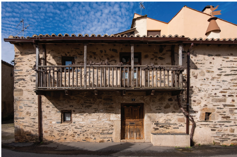
Figura 3. Muros de piedra vista en una rehabilitación en Alcañices. Fuente: Fotografía de C. Hernández.
