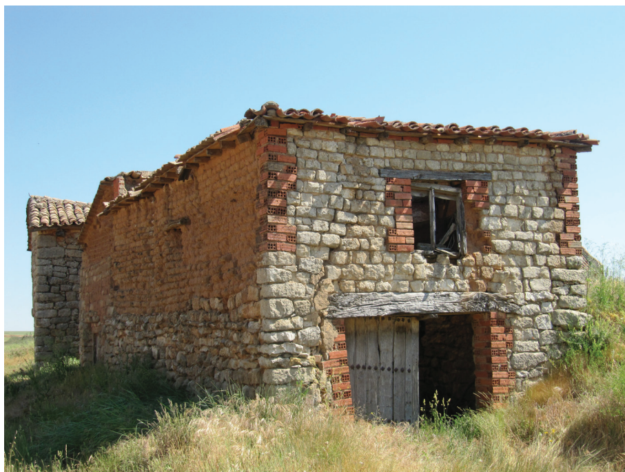
Figura 4. Arenillas de Villadiego (Burgos, España). Construcción popular con diferentes aparejos. Distintos materiales (preindustriales e industriales); misma idea arquitectónica, mismo procedimiento constructivo, similares planteamientos culturales. Fuente: fotografía del autor.
