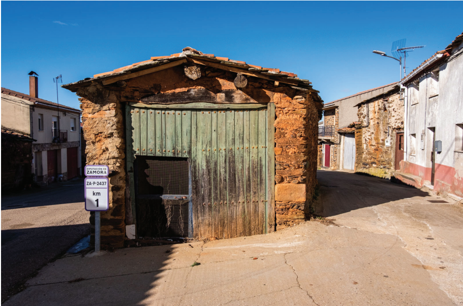
Figura 1. Asedio urbanístico a la construcción vernácula (Trabazos). Fuente: Fotografía de C. Hernández.
