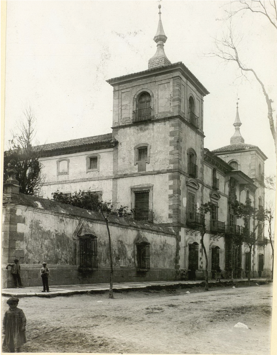
Figura 11. Casa-Palacio de las Torres, Tembleque, años treinta.
