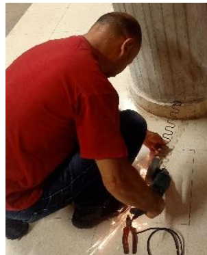
Img 50: Trabajo de corte con la radial
