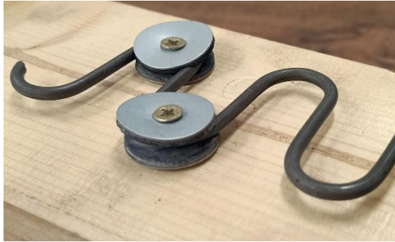
Img 144: Detalle de las arandelas elastoméricas
