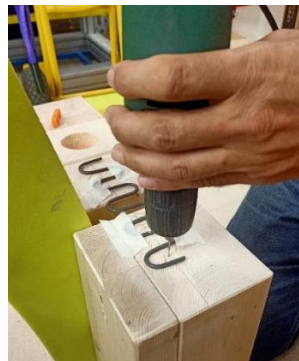
Img 69: Primeras pruebas de colocación
