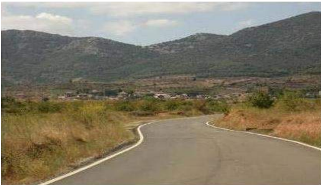
Fotografía nº 5 (tomada en la CV-301, en el punto kilométrico 1)
