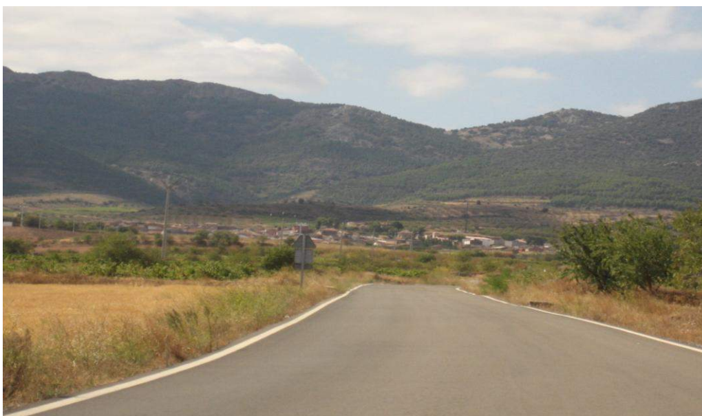
Fotografía nº 4 (tomada en la CV-301, punto kilométrico 0,5 y el punto kilométrico 1)
