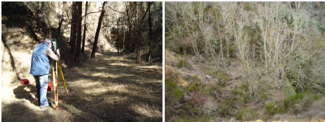
Figura 5.16. Medición de cuña de sedimentos con la estación total (izquierda) y cuña de sedimentos levantada vista desde una cresta con la abundancia de vegetación (derecha).
