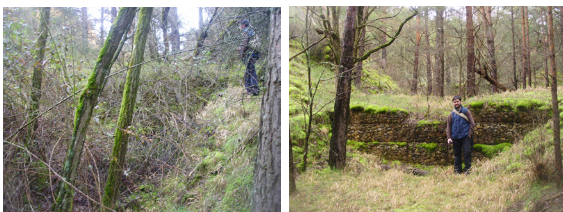
Figura 10.4. Diques 26 (izquierda) y 27 (derecha) fotografiados durante las labores de localización.
