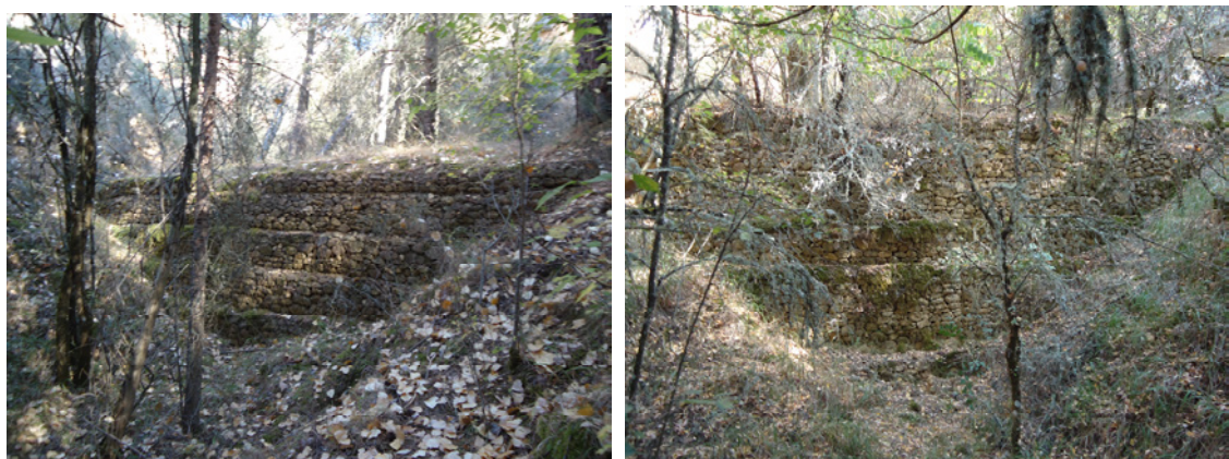
Figura 10.13. Diques 44 (izquierda) y 45 (derecha) fotografiados durante las labores de localización.
