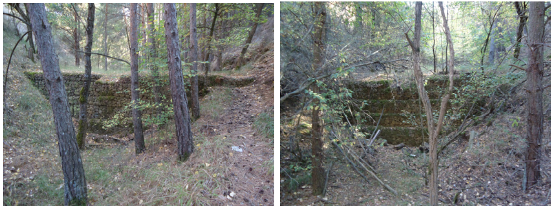
Figura 10.12. Diques 42 (izquierda) y 43 (derecha) fotografiados durante las labores de localización.
