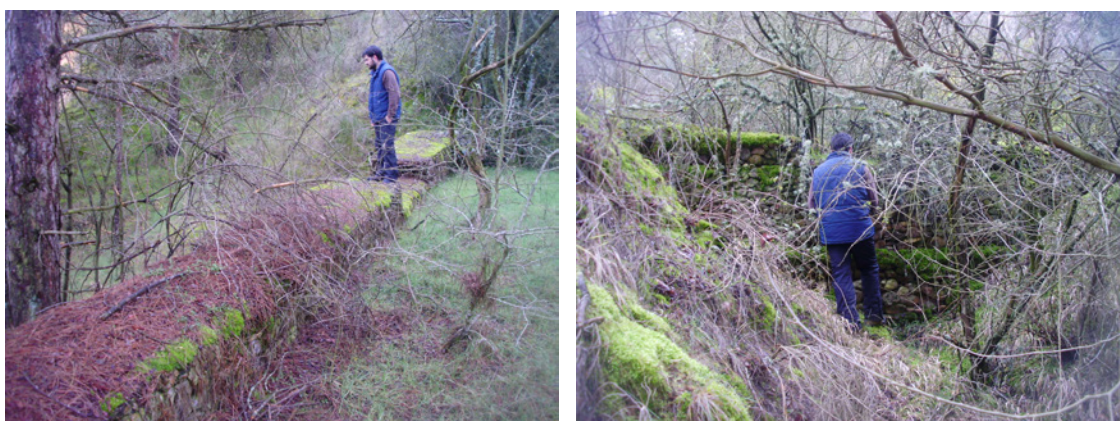
Figura 10.10. Diques 38 (izquierda) y 39 (derecha) fotografiados durante las labores de localización.
