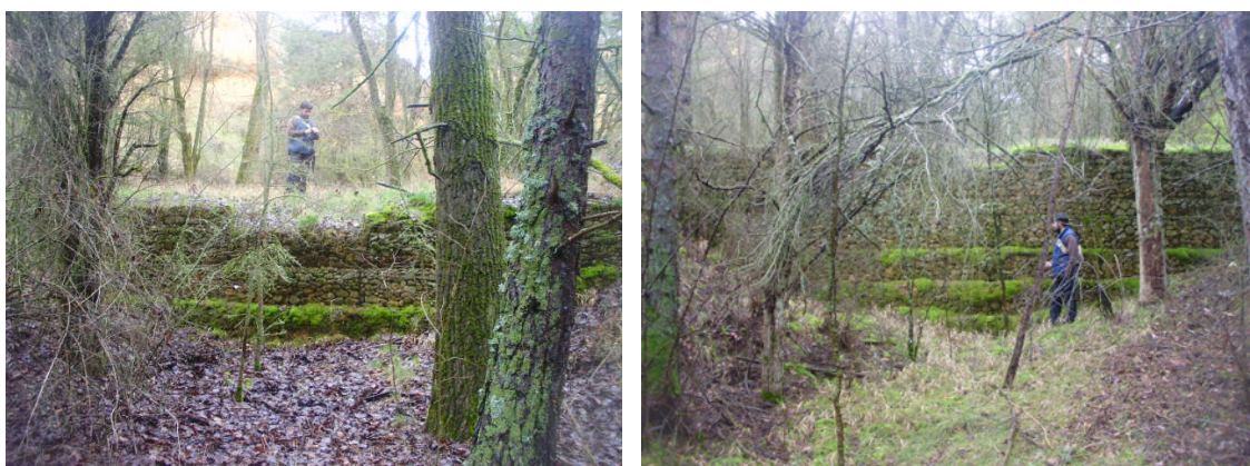
Figura 10.3. Diques 24 (izquierda) y 25 (derecha) fotografiados durante las labores de localización.
