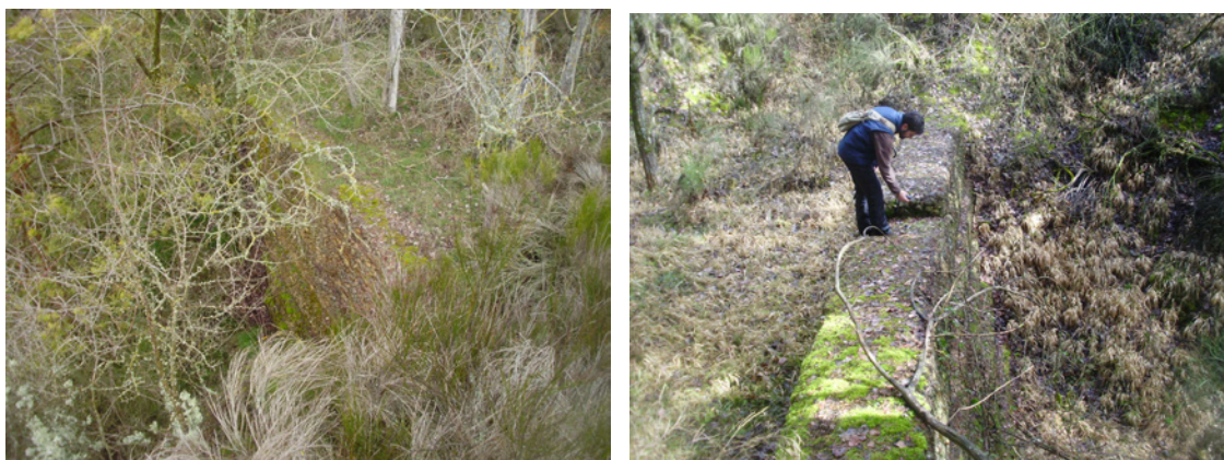
Figura 10.9. Diques 36 (izquierda) y 37 (derecha) fotografiados durante las labores de localización.
