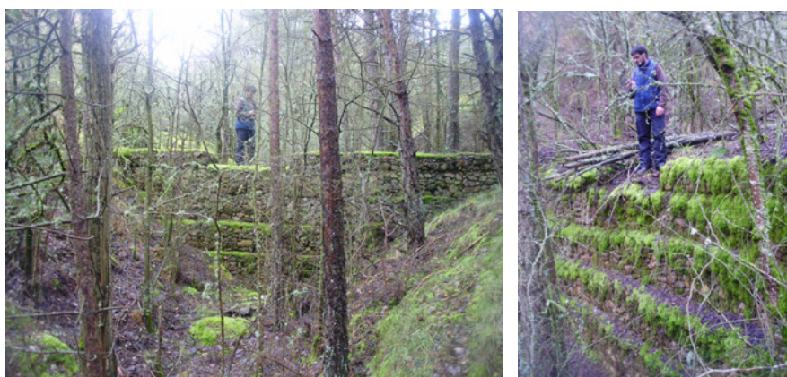
Figura 10.6. Diques 30 (izquierda) y 31 (derecha) fotografiados durante las labores de localización.
