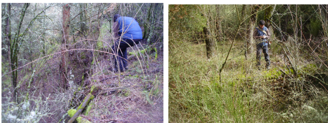
Figura 10.7. Diques 32 (izquierda) y 33 (derecha) fotografiados durante las labores de localización.
