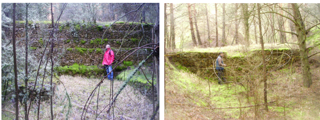
Figura 10.5. Diques 28 (izquierda) y 29 (derecha) fotografiados durante las labores de localización.
