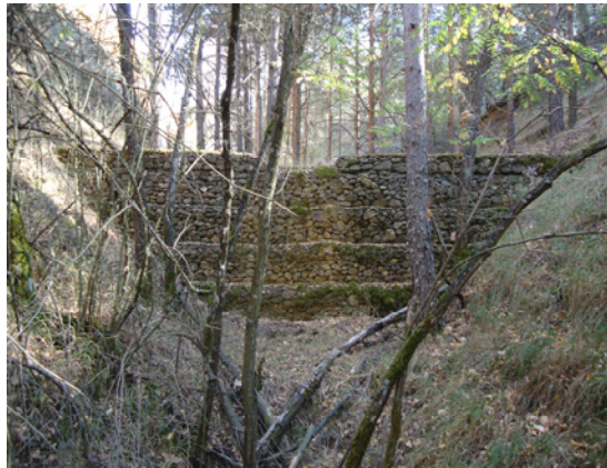
Figura 10.14. Diques 46 fotografiado durante las labores de localización.
