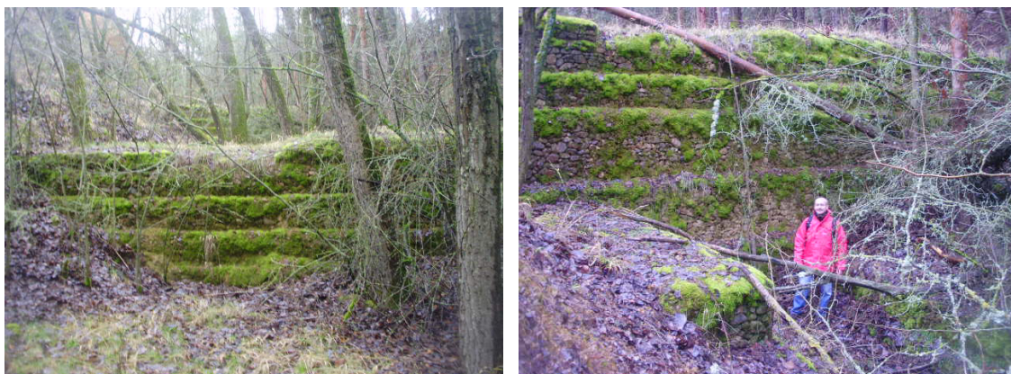
Figura 10.2. Diques 22 (izquierda) y 23 (derecha) fotografiados durante las labores de localización.
