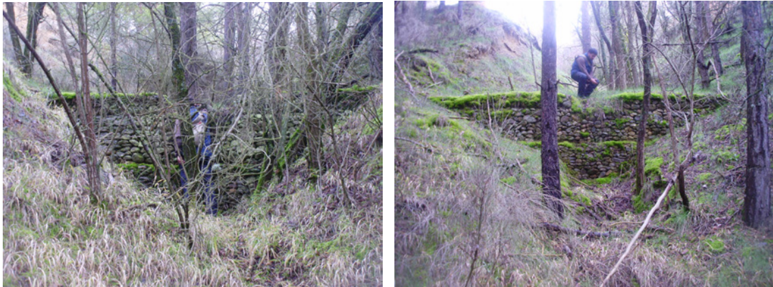
Figura 10.11. Diques 40 (izquierda) y 41 (derecha) fotografiados durante las labores de localización.
