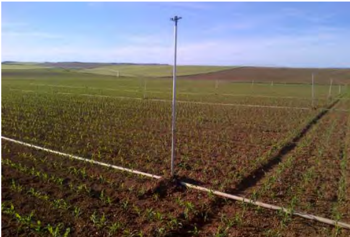
Figura 5.4. Infraestructura de riego por aspersión mediante cobertura total de aluminio en maíz.
