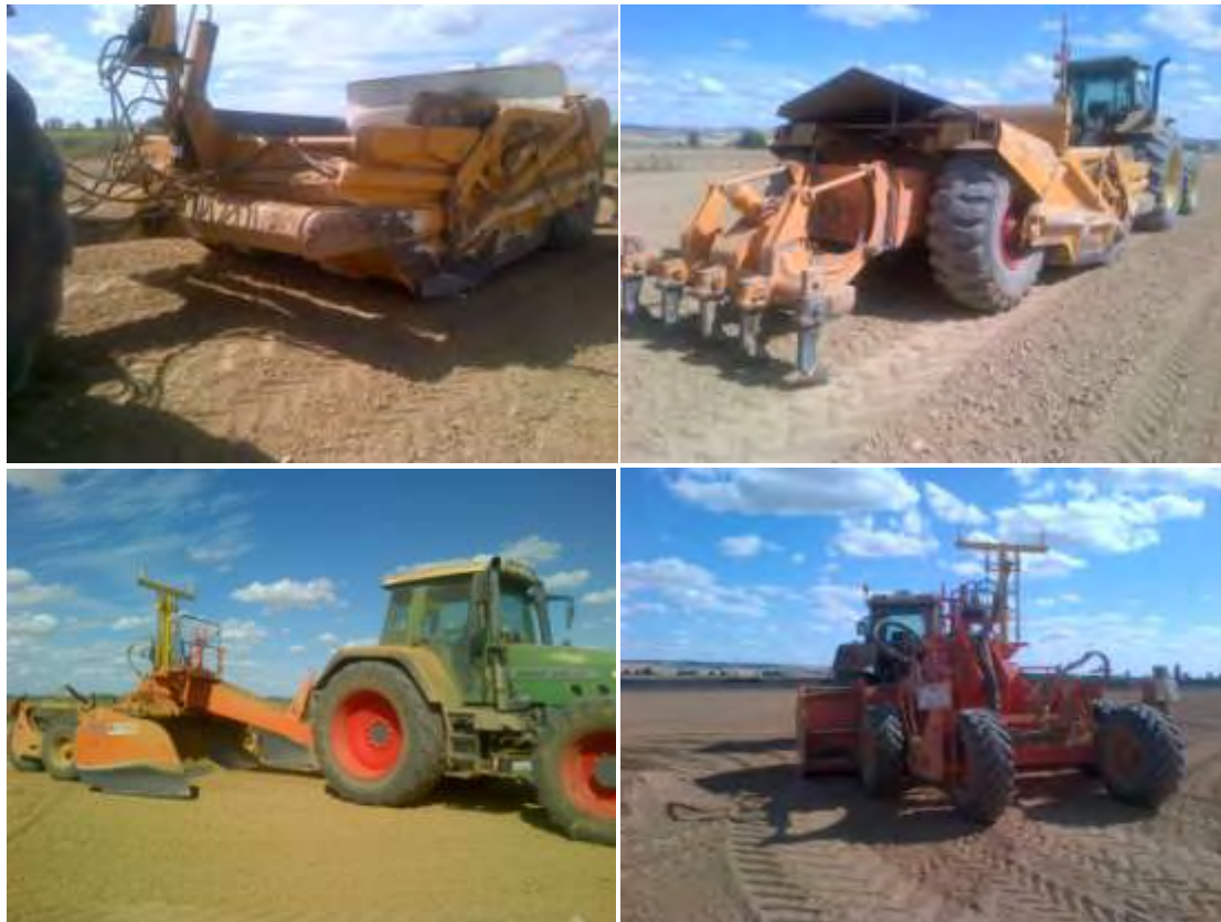
Figura II.2. Maquinaria para el nivelado y refinado de la parcela.
