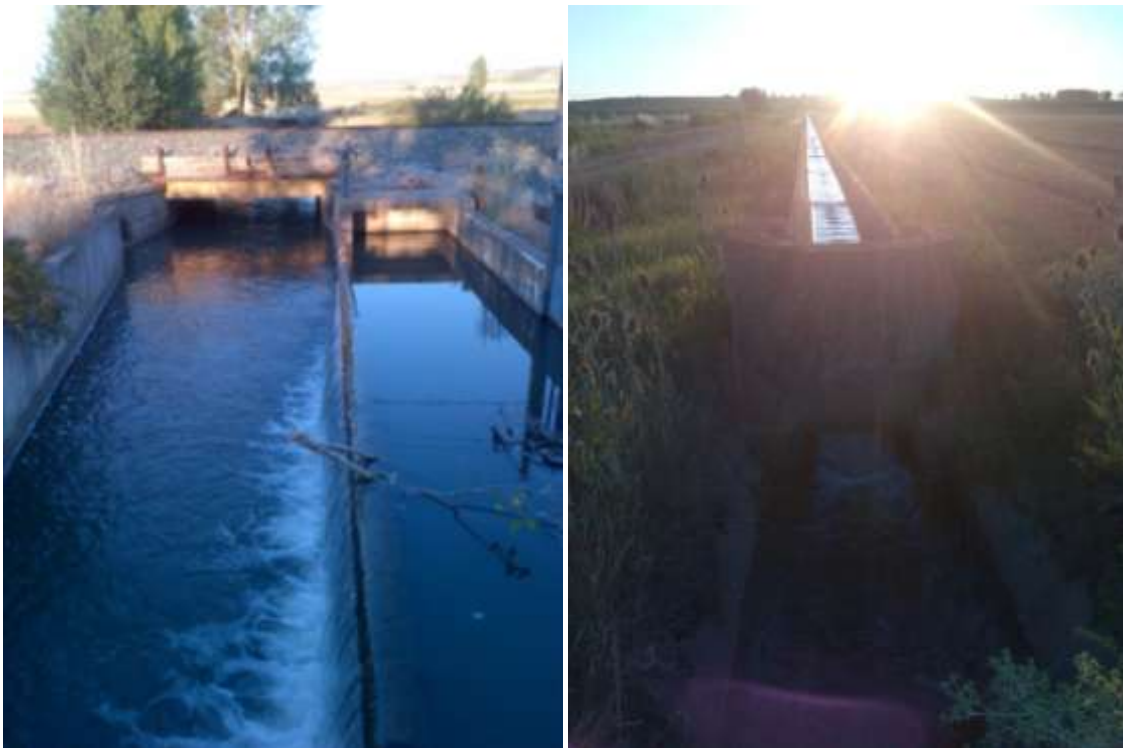
Figura II.1. Red de distribución del sistema de riego por inundación.
