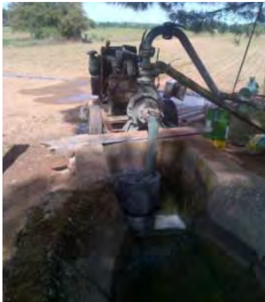
Figura 5.1. Toma de agua del canal.
