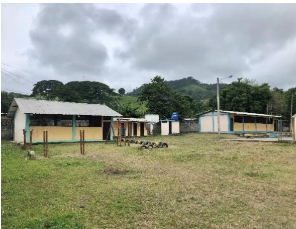
Foto 5.- Aulas de la Escuela Mitad del Mundo y zona de sanitarios
