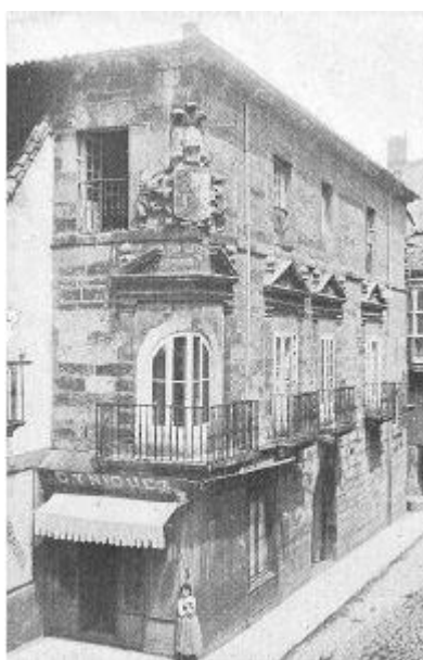
Palacio Rivaherrera en la calle de la Llana, antes del incendio de 1941. Vía CentrodeEstudiosMontañeses.com.
