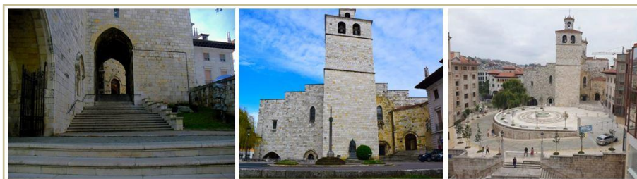
Torre que se realizó a manera de contrafuerte para canalizar los empujes de la construcción. En la parte inferior tiene un arco abovedado para poder atravesarla. Vía ITM, Guía de Cantabria.
