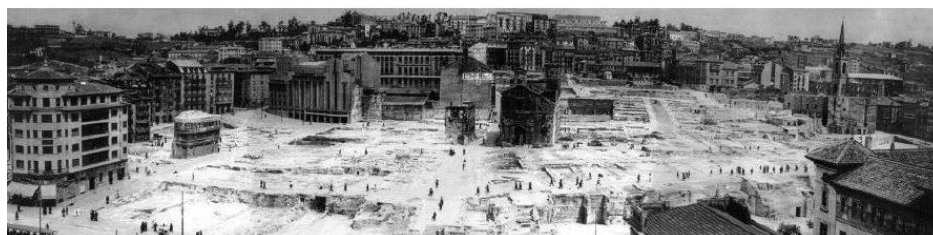
La zona afectada una vez quitados los escombros. Centro de Documentación de la Imagen de Santander.
