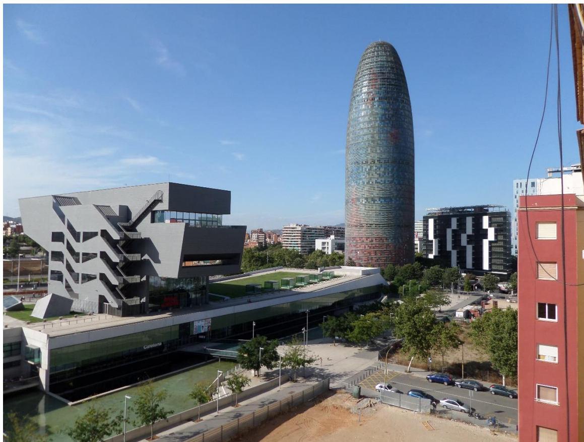
Figura 7. Imagen de la Torre Agbar. Fuente: Fotografía de Federico Camerin (2021).
