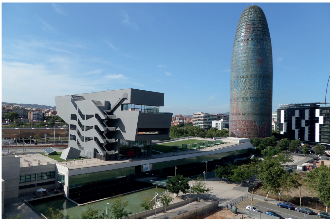
FIG. 10/ El Disseny Hub al lado de la Torre Glòries.
