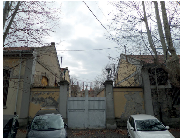
Figura 12. Muro perimetral del cuartel Guido Reni. Fuente: F. Camerin (2022).
