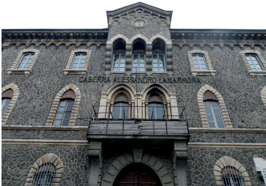
Figura 10. La fachada principal cuartel de estilo neogótico. Fuente: F. Camerin (2022).
