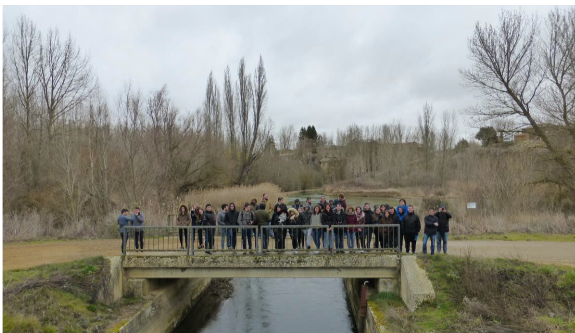
Figura 5. Visita de la asignatura de Planeamiento Urbano y Proyecto de ciudad a Calahorra de Ribas (Palencia). 3 de marzo de 2017.
