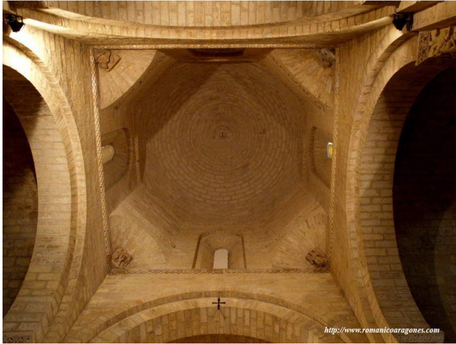
Interior del cimborrio.
