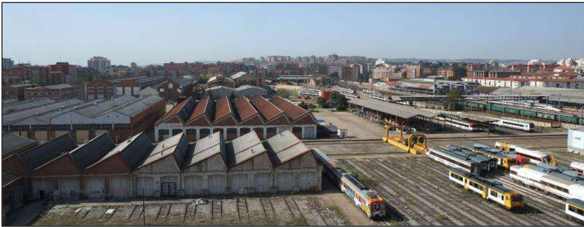
Figura 3: Vista general de los Talleres de RENFE.
