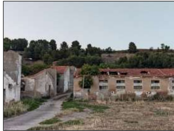
Fotografía 3: Antigua granja. Sector las Cerámicas.
