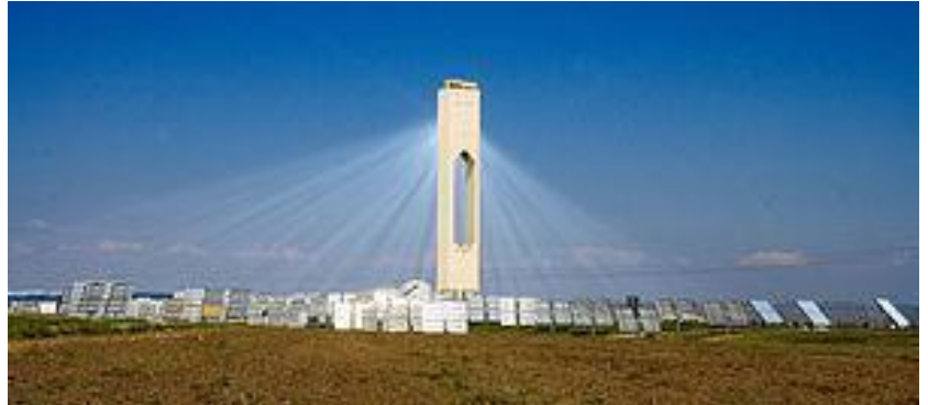
Ilustración 6: Torre de acumulación solar de muy alta temperatura.
