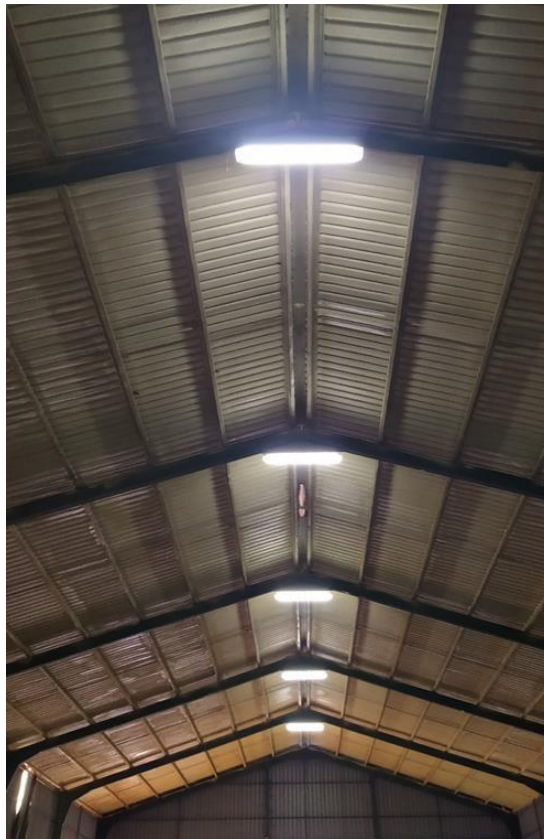
Fotografía 2: Tejado de la nave agrícola visto desde el interior.
