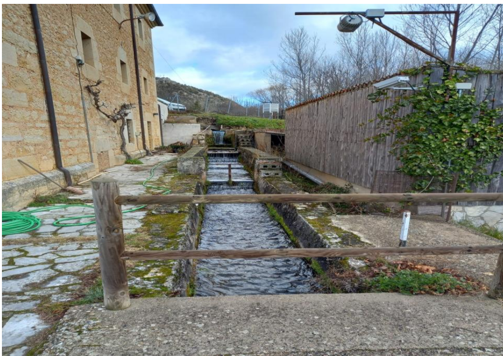
Figura 14: Entrada de agua hacia la piscifactoría.
