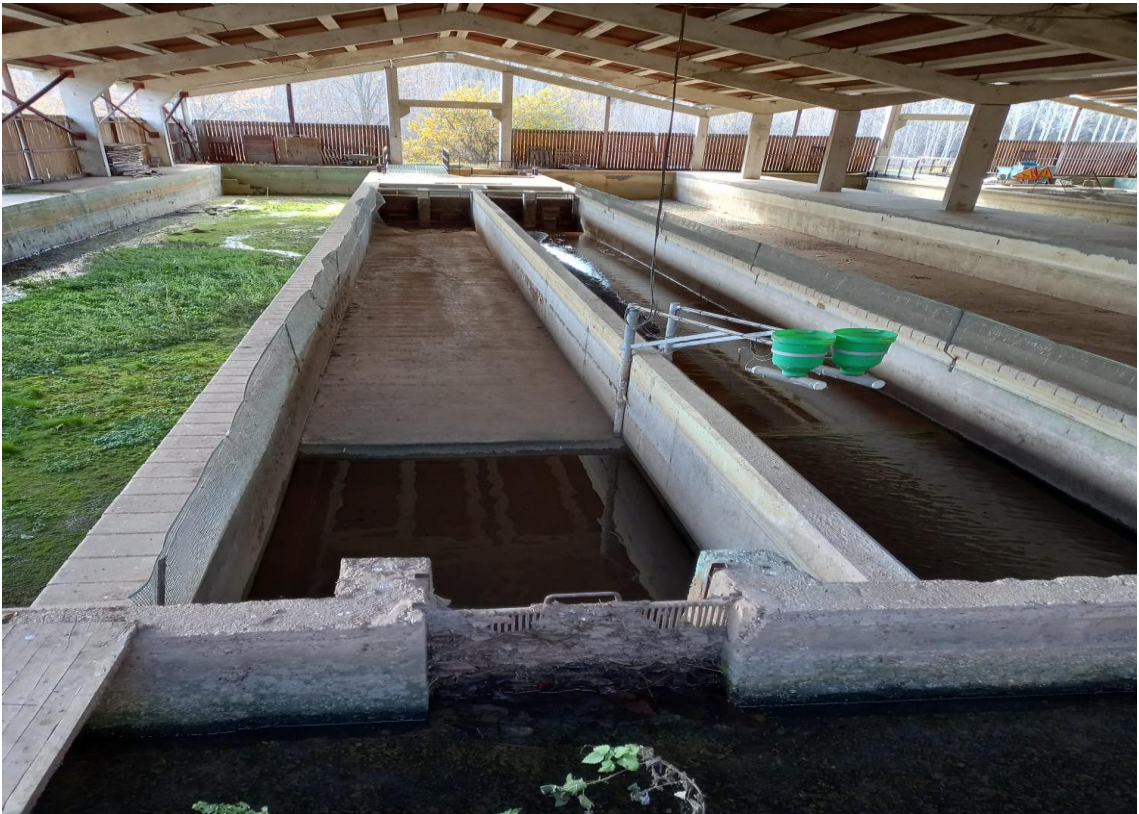
Figura 63: Estanques batería C. Solera en tierra. Actual.
