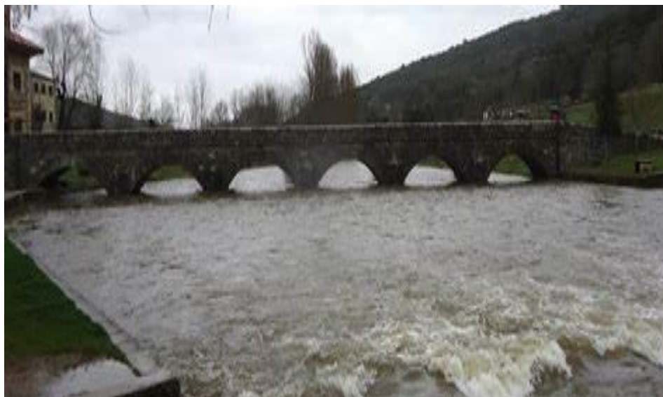
Figura 73: Inundación del Río Ucero en El Burgo de Osma; Fuente: Internet.
