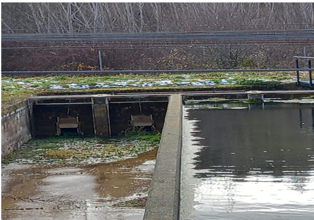
Figura 45: Rejillas de los estanques de la batería B, 2 por cada estanque.
