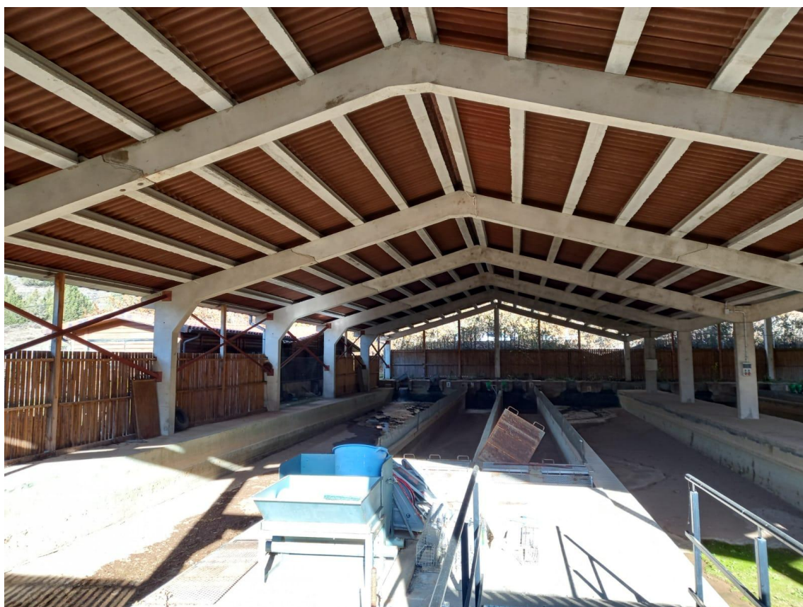
Figura 50: Vista general de los estanques interiores.
