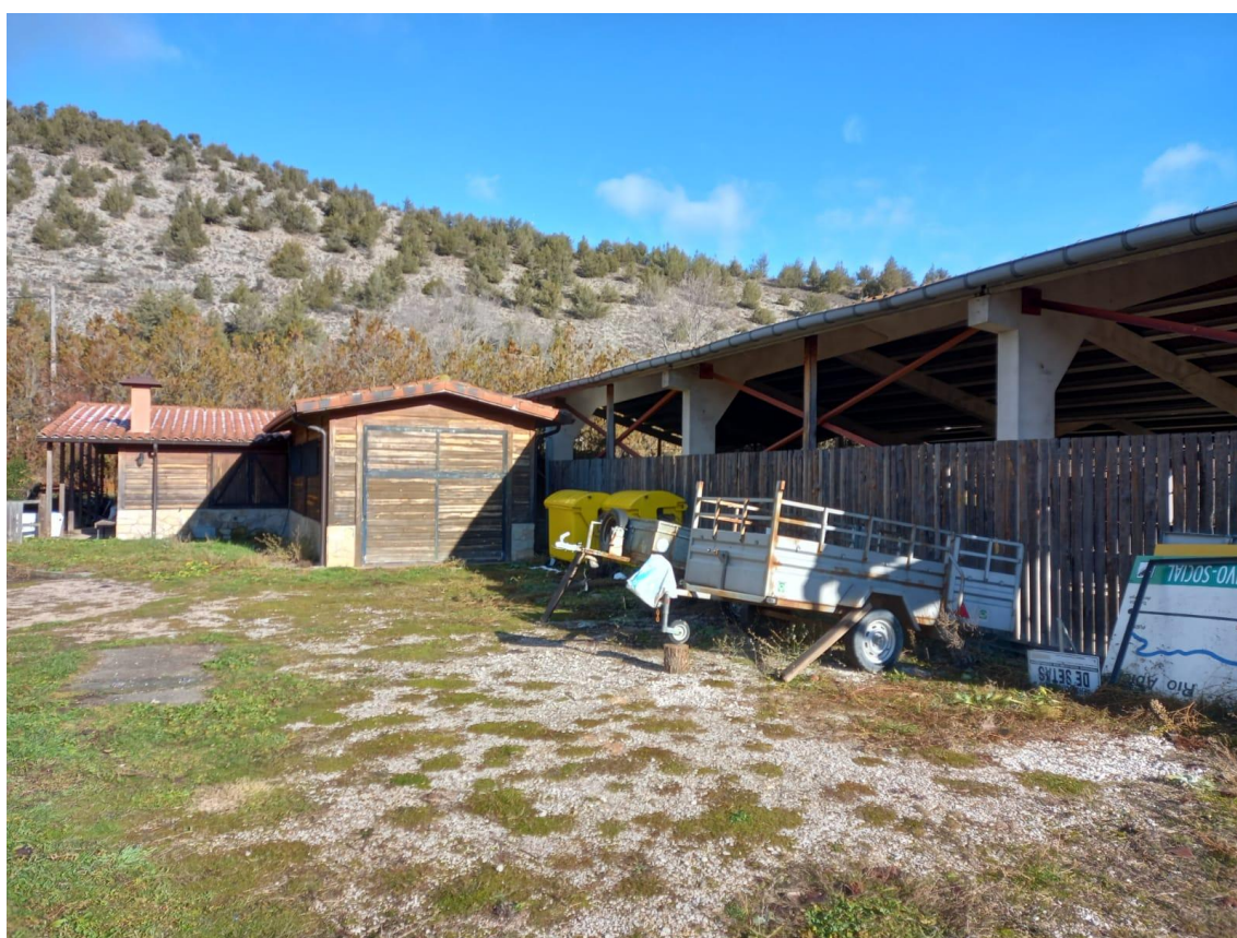
Figura 48: Exterior de los estanques interiores.
