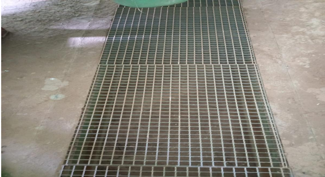
Figura 23: canal de desagüe, con malla de pletina electrosoldada.
