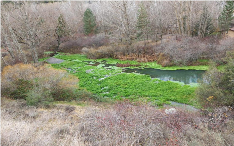
Figura 7: Vista general de la presa
