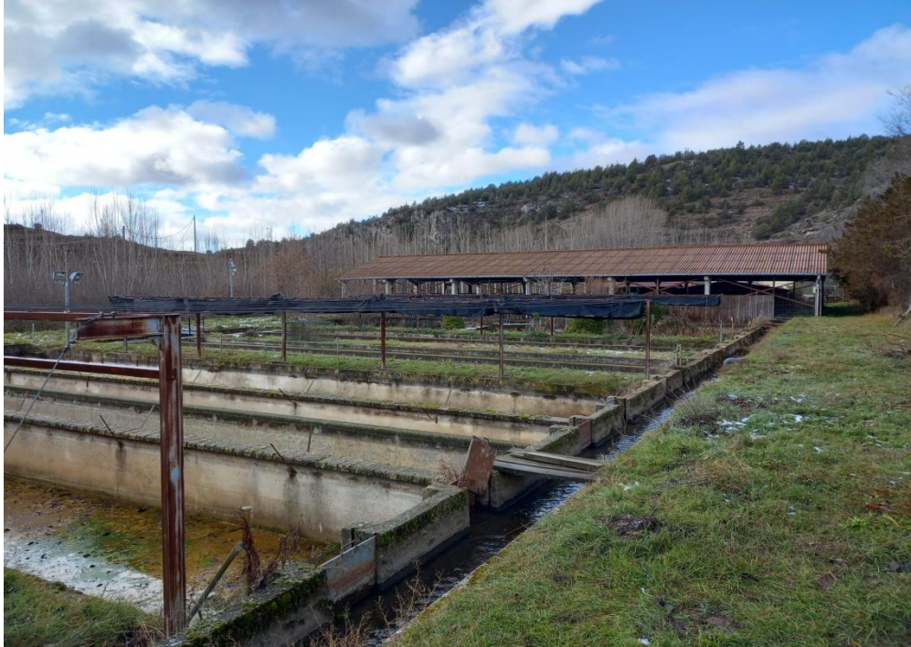
Figura 34: Vista general estanques exteriores.
