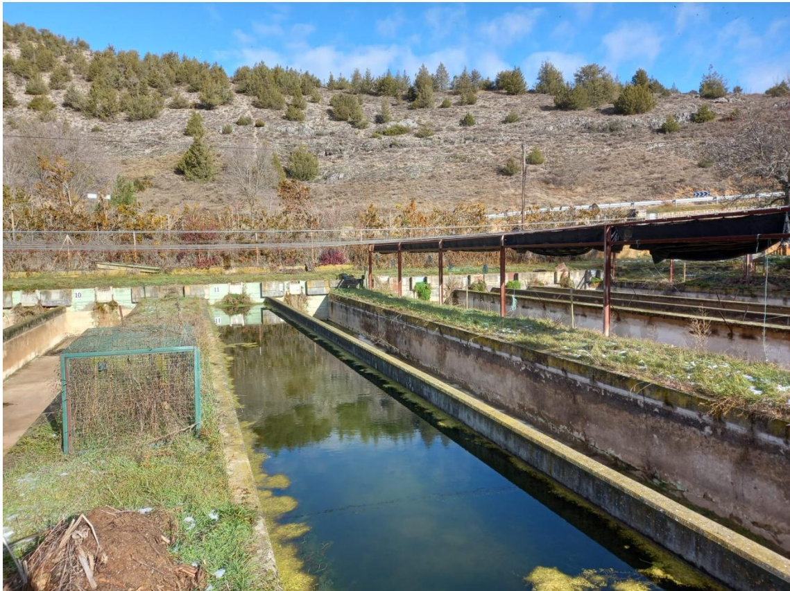
Figura 42: Estanques cubiertos por los cables para evitar depredación y estructura de sombreo.
