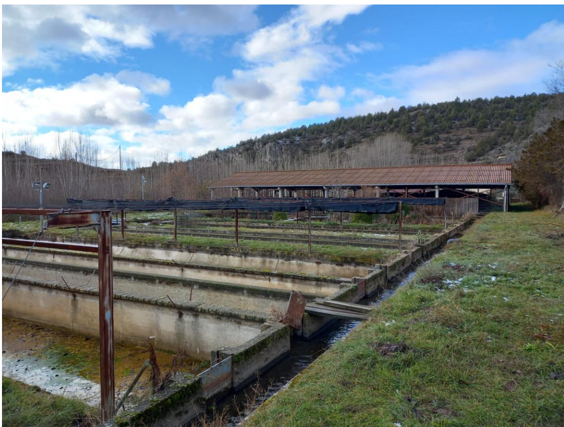
Figura 59: Vista general estanques (Baterías A, B, C y D). Actual.
