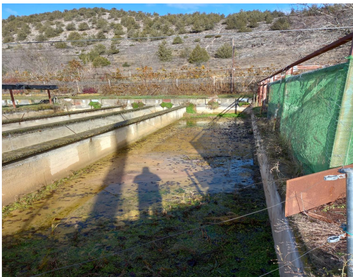
Figura 61: Estanques Batería A. Actual.
