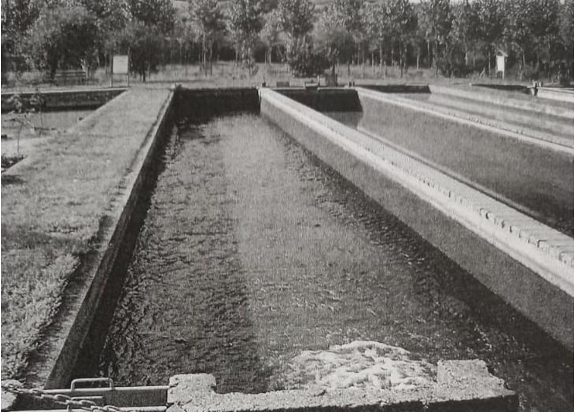
Figura 62: Estanques batería C. Solera en tierra. Antiguo.
