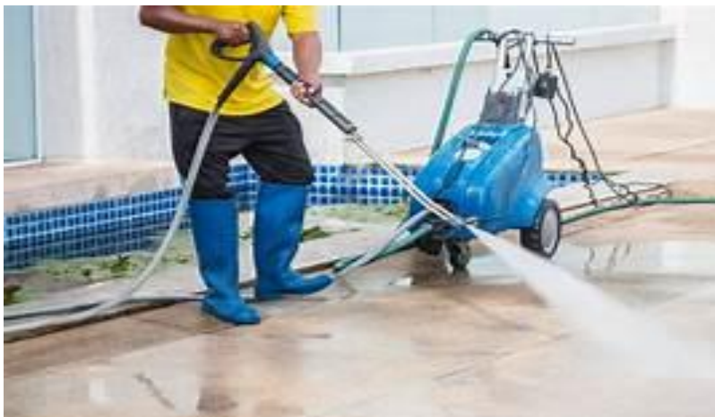
Figura 86: Limpieza con agua a presión; Fuente: Internet
