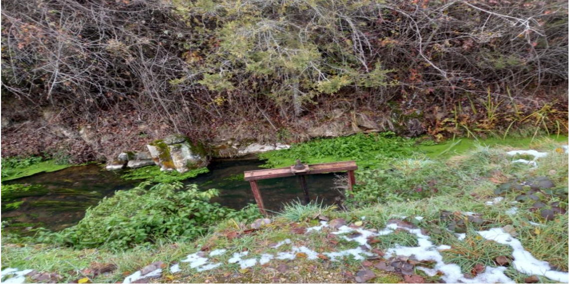
Figura 10: Tajadera para regular la entrada de agua en la balsa de decantación.
