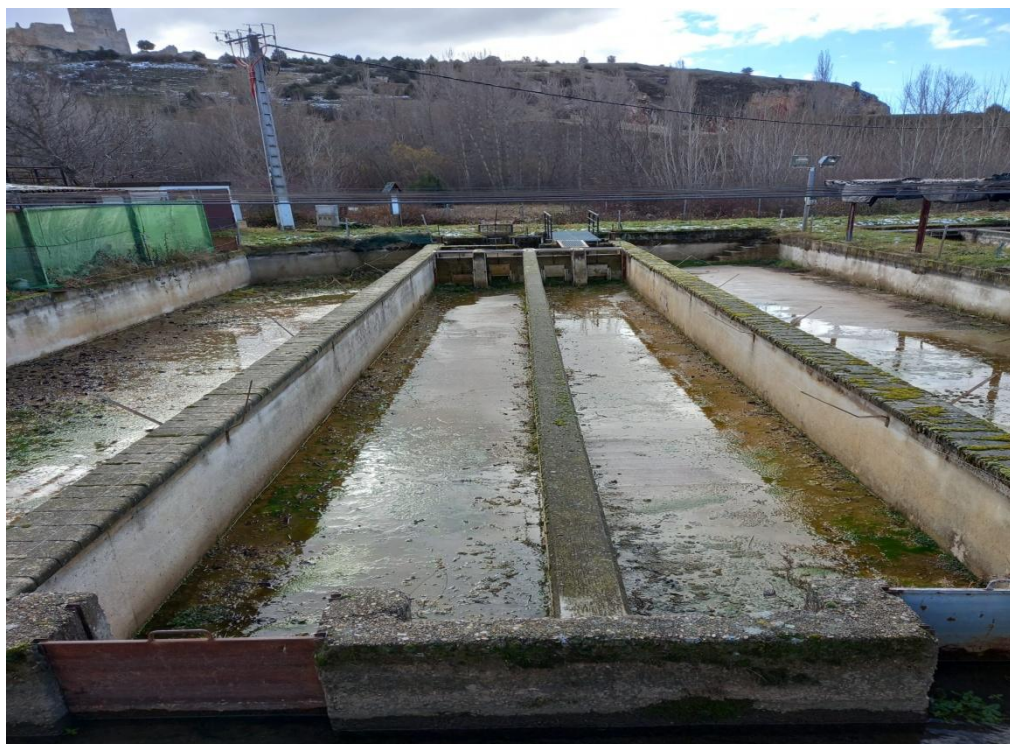
Figura 36: Estanques de la batería A.
