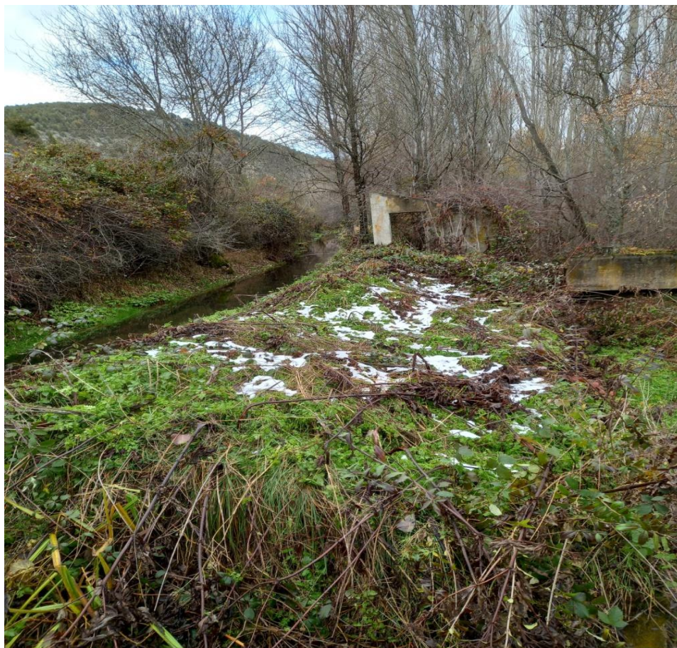
Figura 9: Vista del canal antes de llegar a la primera balsa de decantación
