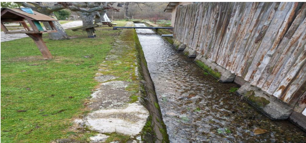
Figura 16: Aspecto del canal en la entrada de agua a las salas de alevinaje.
