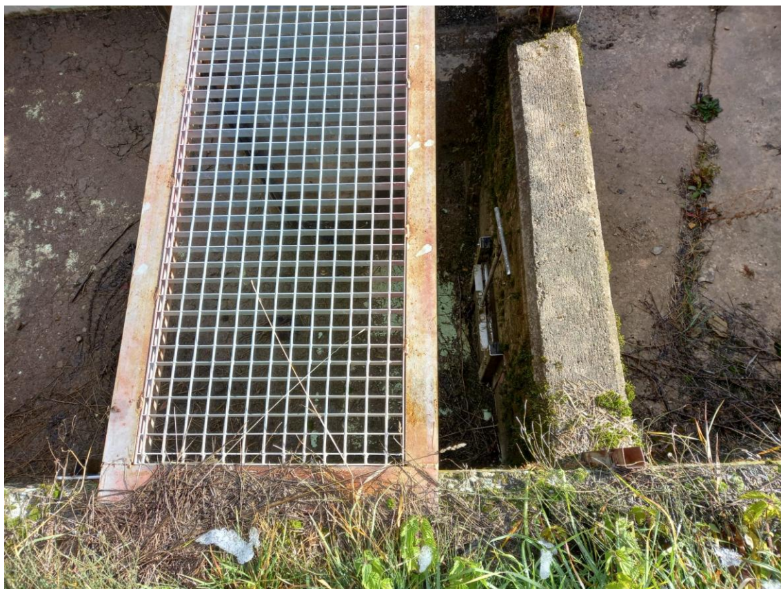
Figura 38: pasarela y muro que sostiene las rejillas de chapa perforada.
