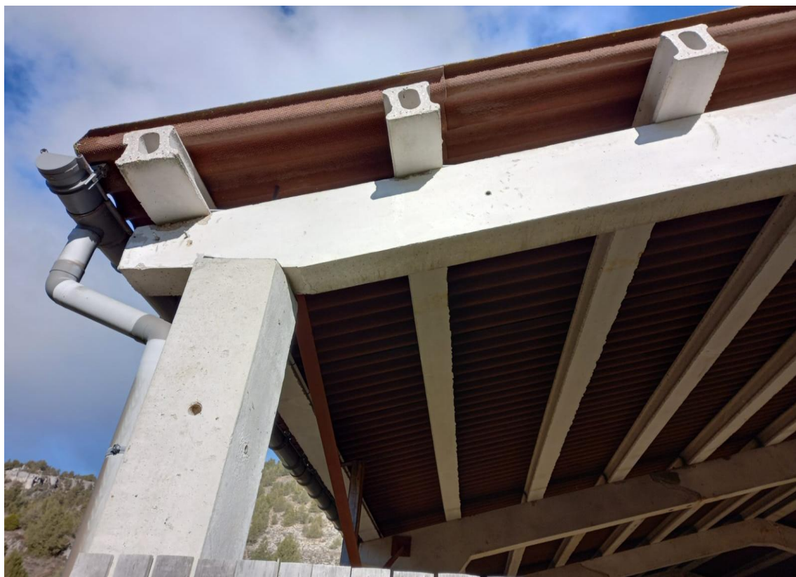
Figura 49: Cubierta de los estanques interiores.
