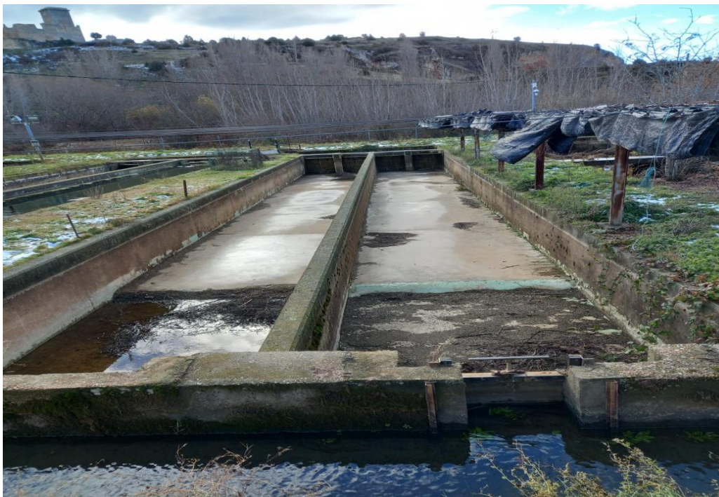
Figura 44: Segundo grupo de estanques de la batería B.
