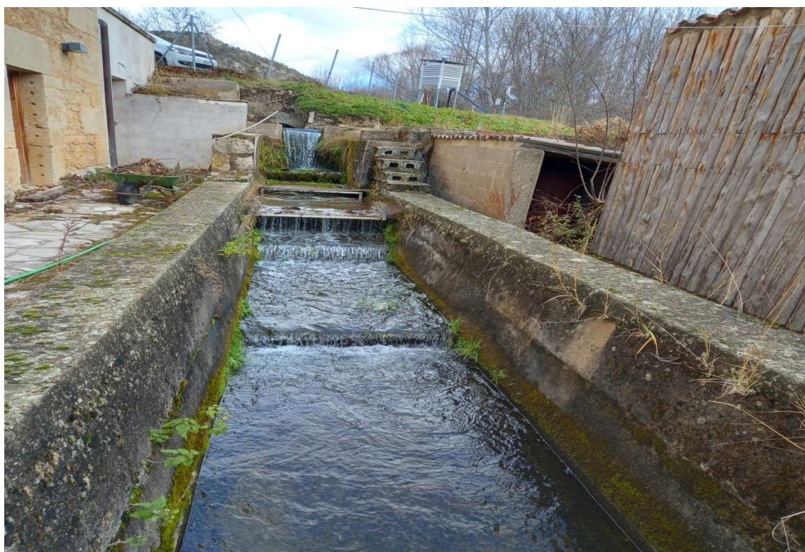
Figura 57: Canal de distribución general. Lugar de ubicación de rejilla de desbaste. Actual.
