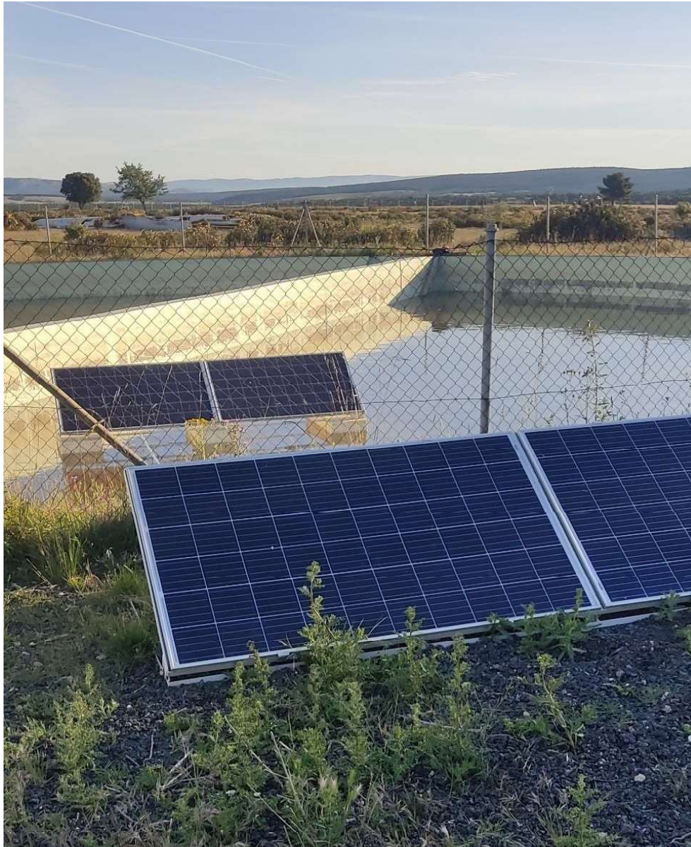
Figura 12: Paneles instalados en tierra y en agua.
