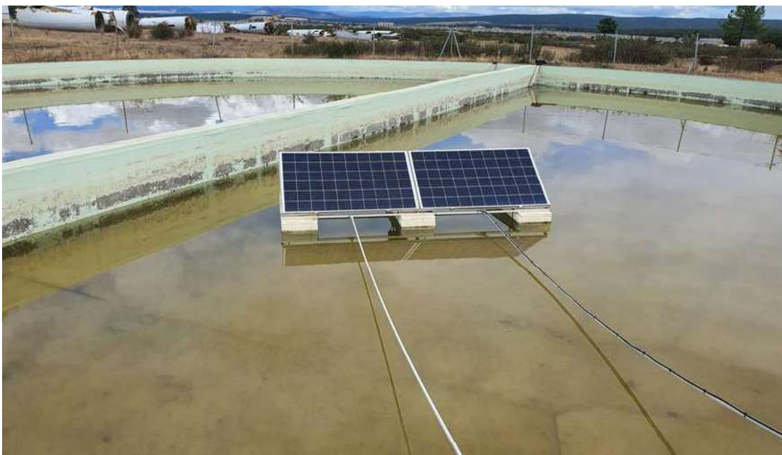
Figura 21: Módulos instalados en agua.
