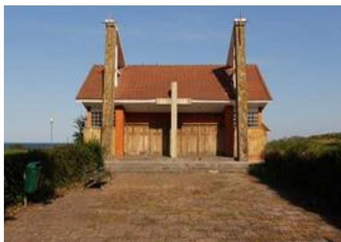
Ilustración 69; Vista frontal de la Iglesia. Fuente:
