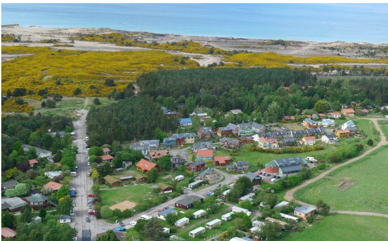
Ilustración 83; Estado actual de las viviendas de la ecoaldea de Findhorn. Fuente: https://www.pinterest.es/pin/420453315187296976/
