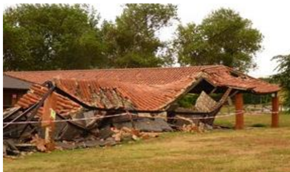
Ilustración 72; Colapso del pórtico de Carranques. Fuente: https://unfuturoparaperlora.blogspot.com/
