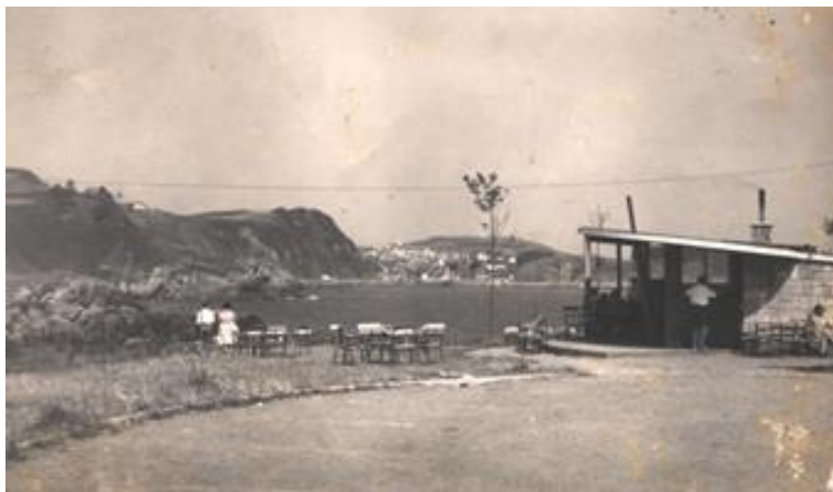
Ilustración 74; Estado Original de La Cabaña. Fuente: https://unfuturoparaperlora.blogspot.com/
