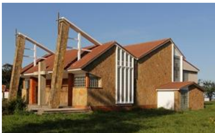
Ilustración 68; Vista lateral de la Iglesia donde se aprecia la estructura exterior. Fuente:
