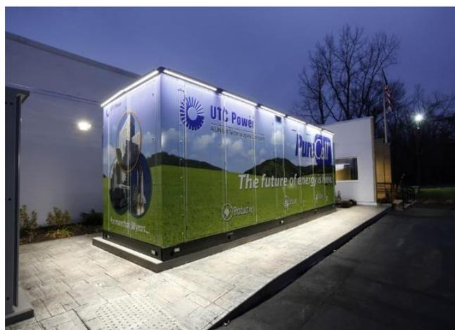
Figura 55: Sistema de potencia PureCell, que suministra 400 kW de potencia. Fuente: [37]
