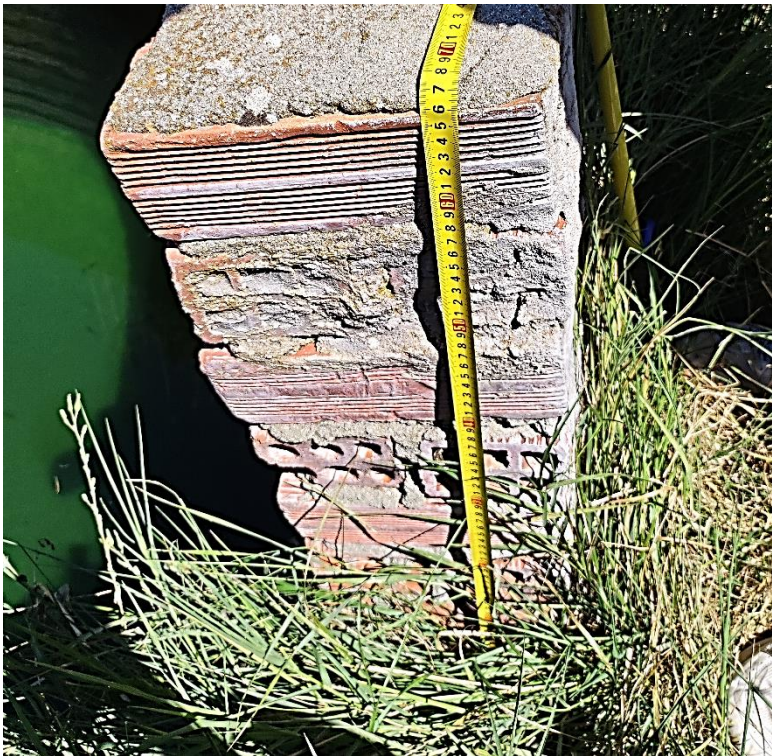
Ilustración 3. Altura del muro del pozo desde el suelo.
