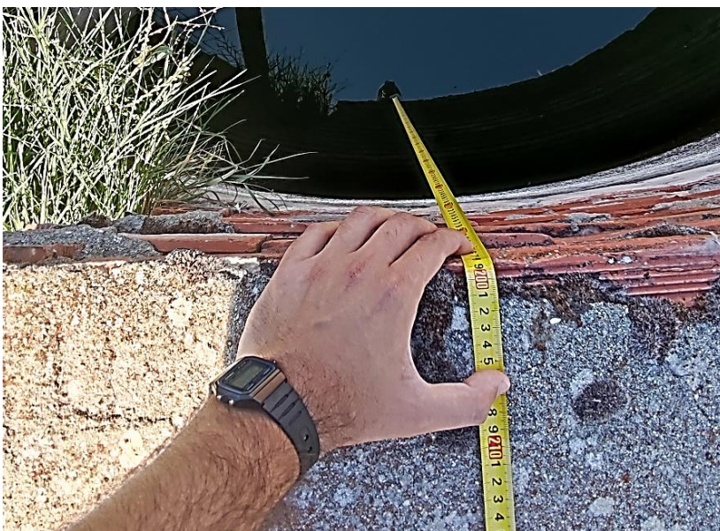
Ilustración 2. Profundidad del pozo medida desde el muro del pozo.
