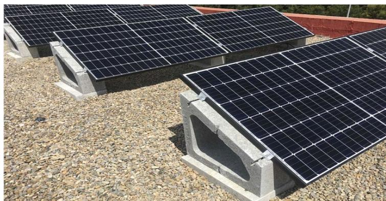
Figura 28: Colocación de panel sobre soporte y sistema de anclaje
