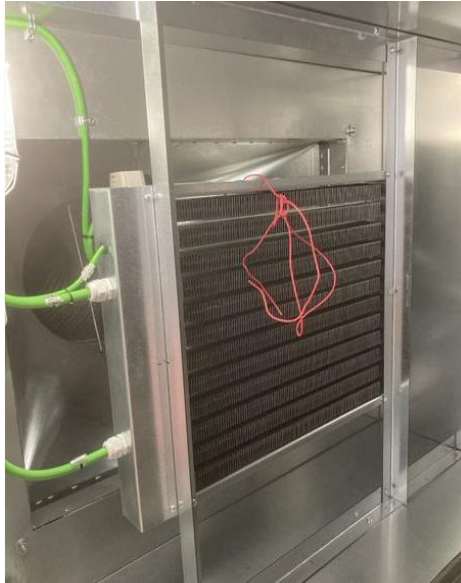
Figura 10: Resistencia eléctrica de post-calentamiento
