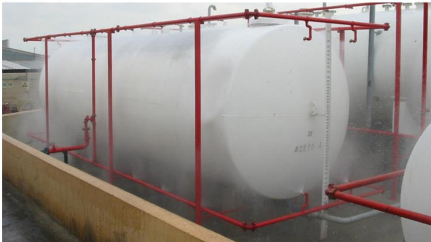
Figura 8: Sistema de agua pulverizada
