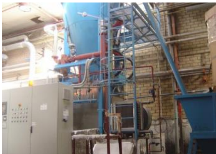
Figura 9. Preexpansor en fábrica [Turq.].
