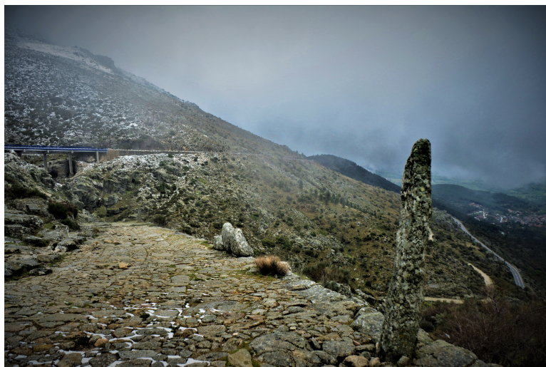
Figura 1.4: Evolución de las calzadas ante las salidas de vía (sin y con Sistema de Contención, con dos mil años de diferencia entre ambas). Fuente: @Aquilino Molinero.
