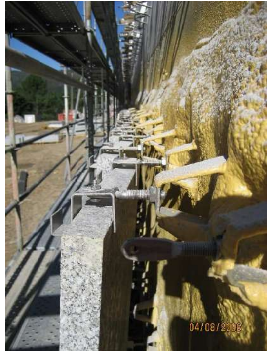
Colocación de placas. Cedidas por el estudio de arquitectura
