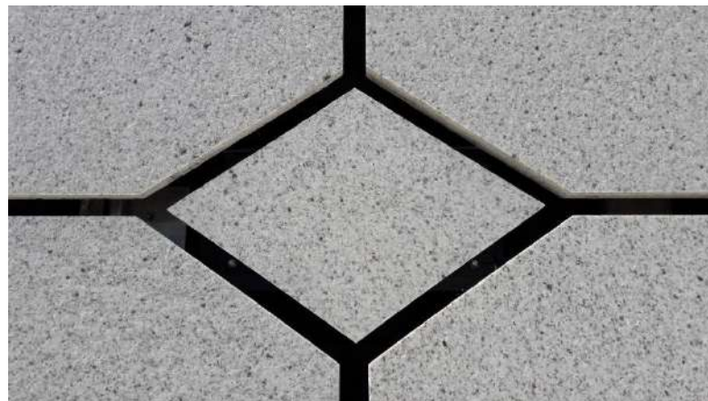
Tipos de juntas. Arriba fachada original. Abajo reconstrucción. Fotografías de la autora
