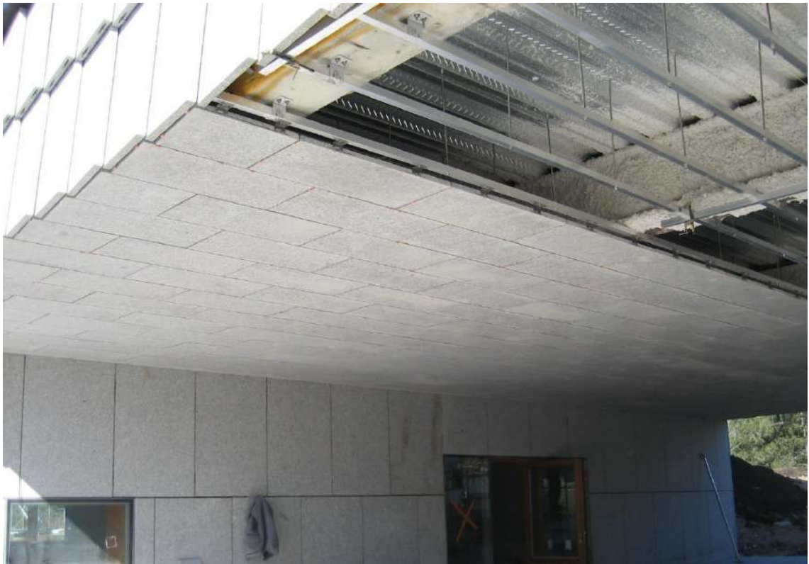
Instalación de falso techo. Cedida por el estudio de arquitectura
