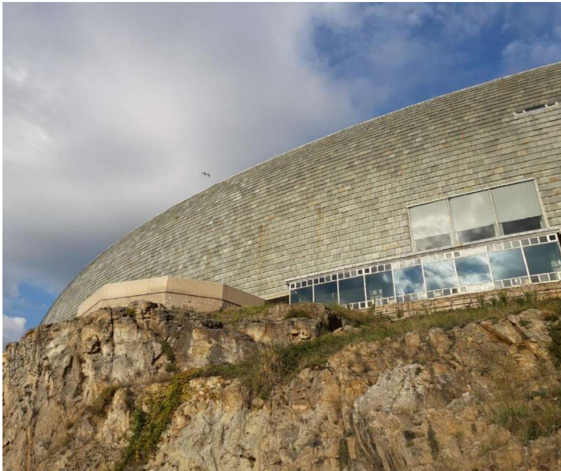
Fachada sur. Fotografía de la autora
