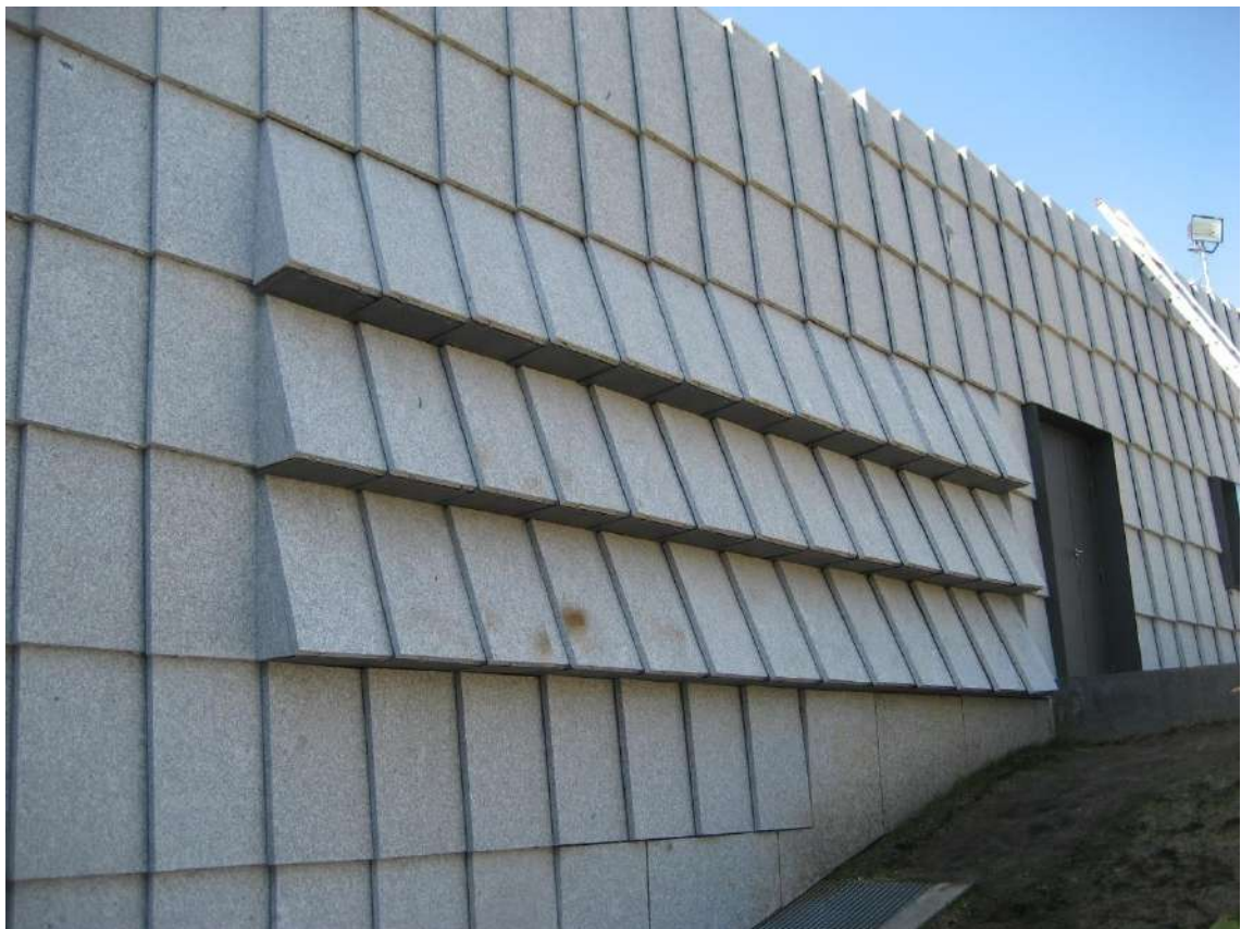
Encuentro con aberturas de ventilación. Cedida por el estudio de arquitectura
