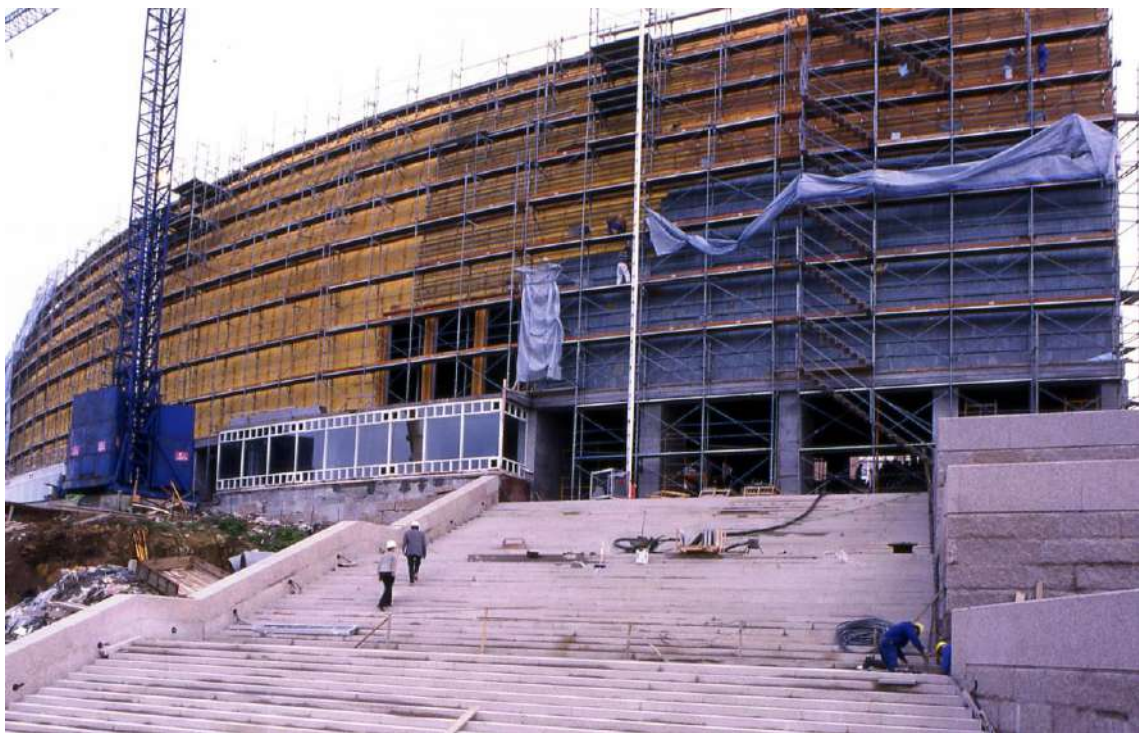
Imagen tomada durante la instalación del subsistema. Cedida por Arata Isozaki & Asociados España S.L.
