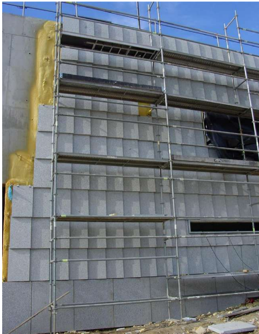
Colocación de placas. Cedida por el estudio de arquitectura
