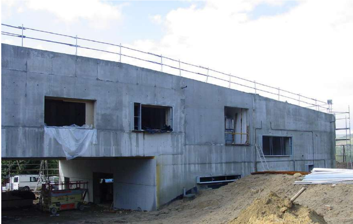
Muro de hormigón armado. Cedida por el estudio de arquitectura
