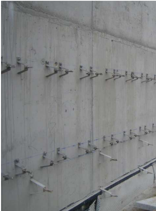
Colocación de anclajes y proyectado de aislamiento. Cedidas por el estudio de arquitectura
