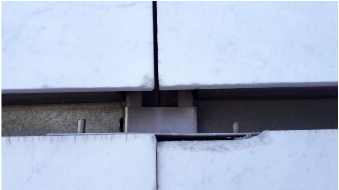
Detalle anclajes cara superior de las placas. Fotografías de la autora
