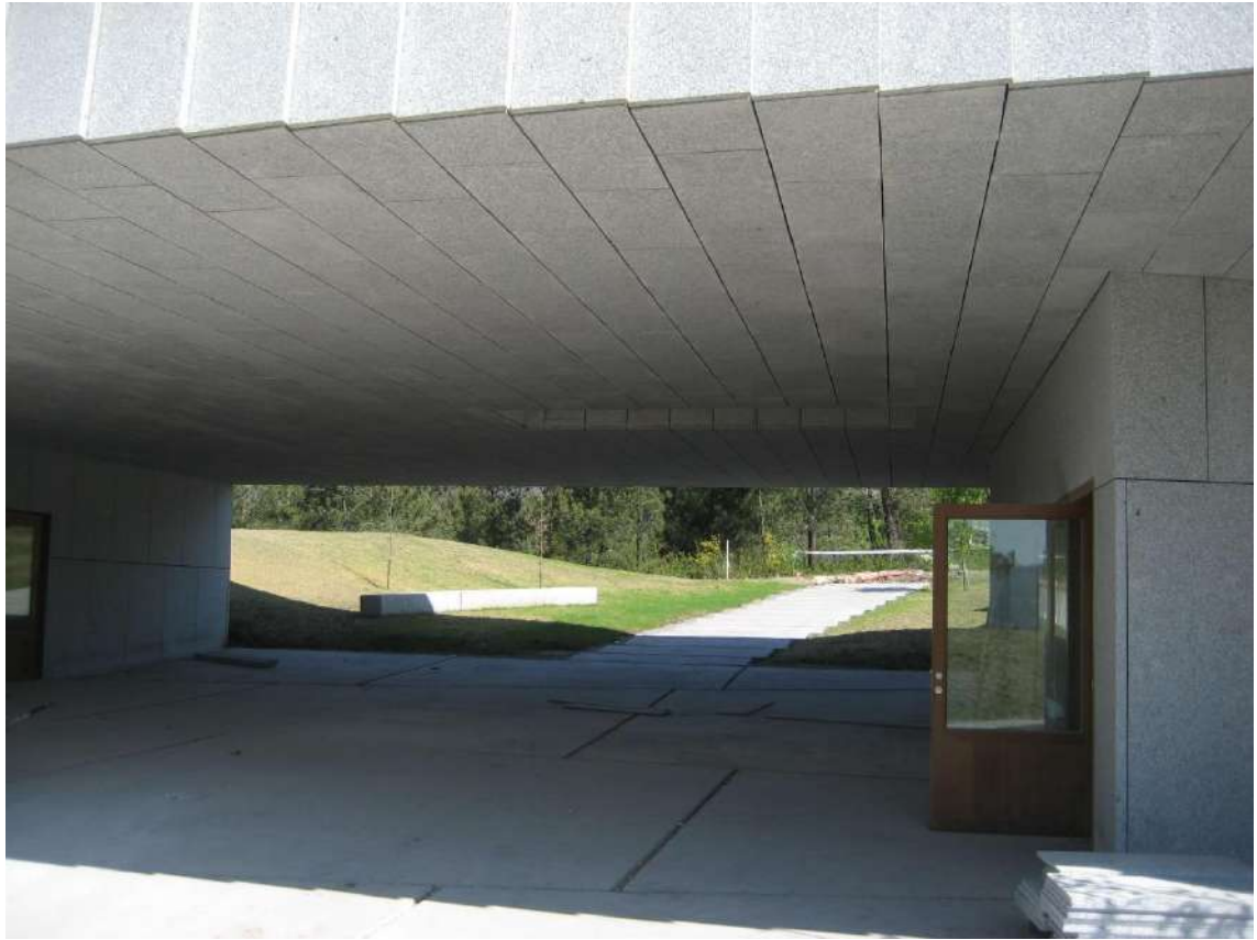
Remate inferior. Encuentro con falso techo. Cedido por el estudio de arquitectura
