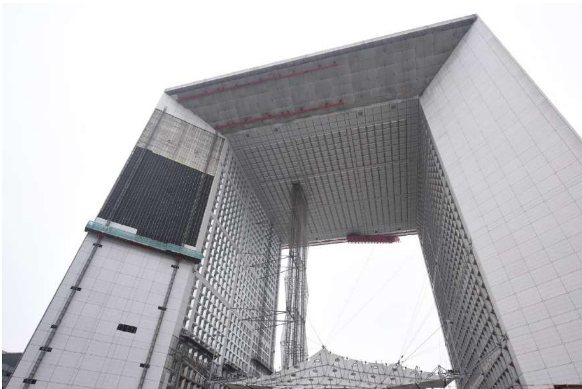
Obras Fase 1. Montaje nueva fachada. Imagen google maps https://www.google.com/maps/place/Arco+de+la+D%C3%A9fense (consultado el 01 de octubre de 2016)
