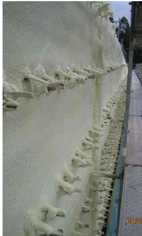
Colocación de anclajes y proyectado de aislamiento. Cedidas por el estudio de arquitectura
