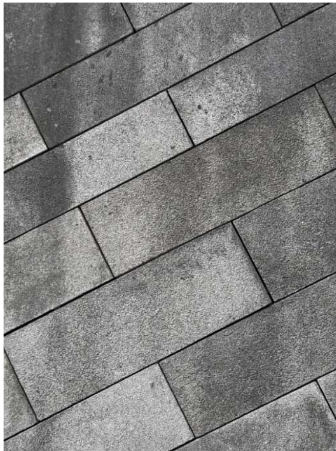
Imagen despiece inclinado piedra. Fotografía de la autora
