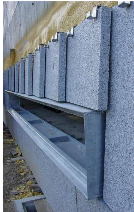
Instalación de carpintería. Cedidas por el estudio de arquitectura
