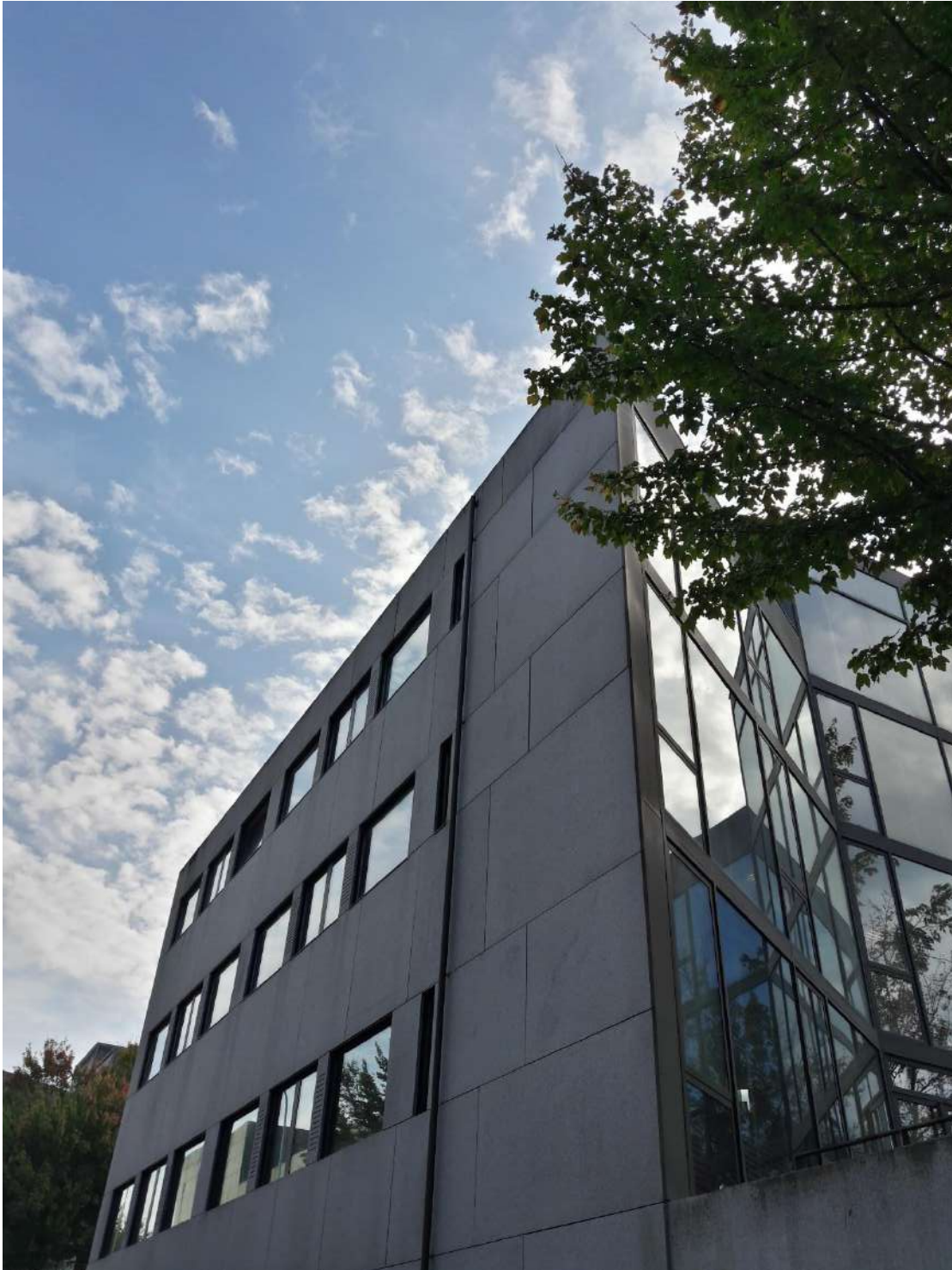
Fachada sur. Fotografía de la autora
