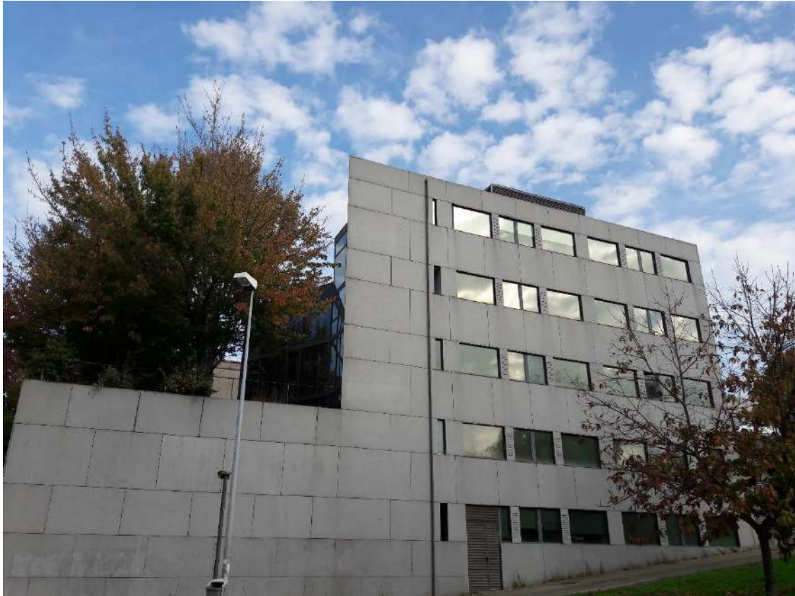
Fachada norte. Fotografía de la autora
