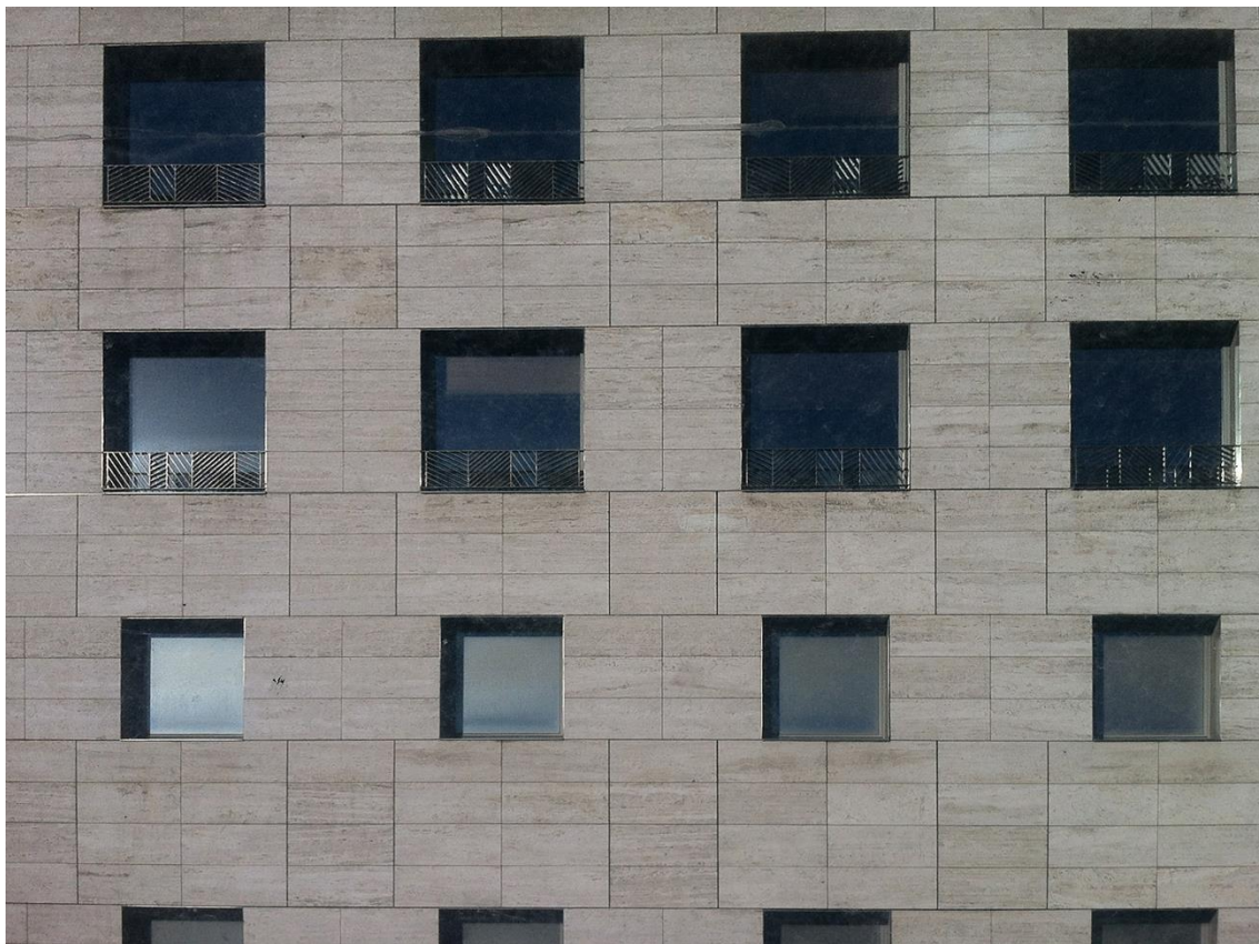
Figura 5.49. Edificio Diagonal en Barcelona. Rafael Moneo (1986-1993) Apart-Hotel Citadines en Barcelona. Croquis, N° 64, 1994, pp. 102-119
