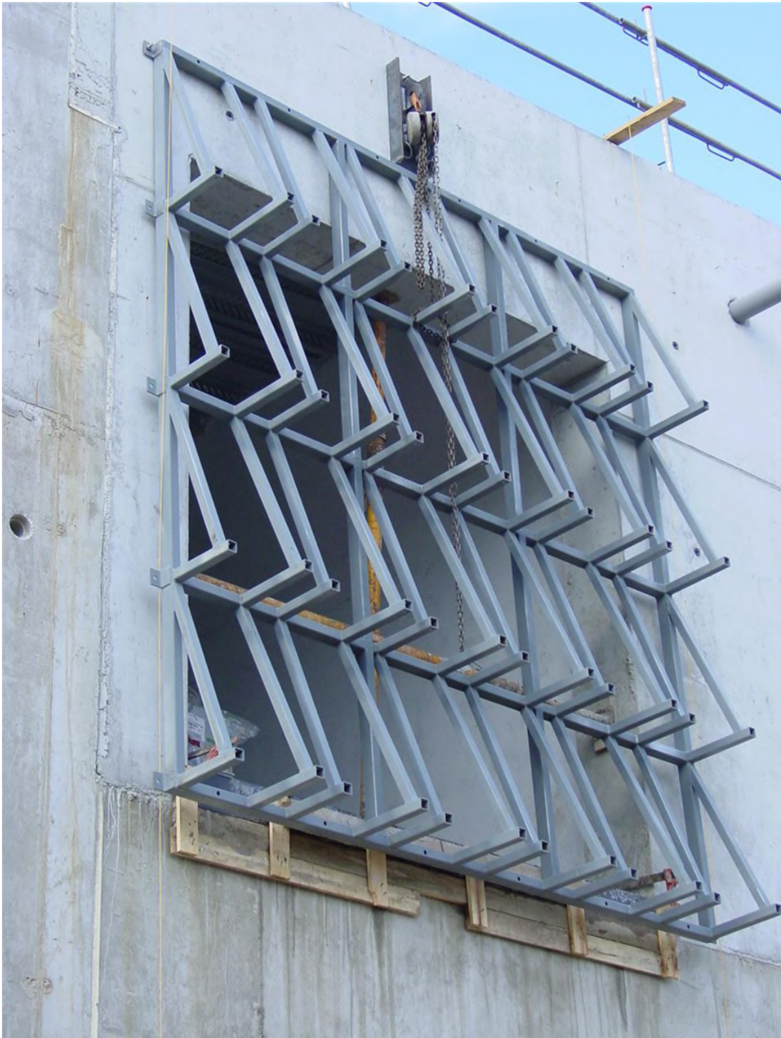
Figura 5.55 Instalación de elementos de ventilación. Fotografía cedida por el estudio de arquitectura.
