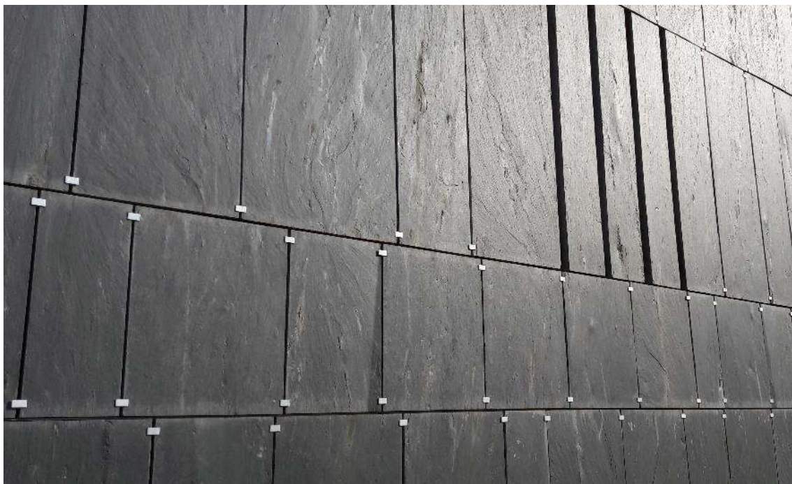
Figura 3.37 (arriba). Edificio para el Nuevo Parlamento en Malta. Placas volumétricas con funciones de soleamiento. Michel Denancé. https://arquitecturaviva.com/obras/puerta-de-la-valeta . (Consulta el 08.09.2020) Figura 3.38 (abajo). Centro de salud en Monterroso. Fijaciones vistas. Fotografía de la autora
