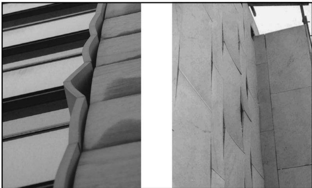
Figura 3.3. Dilatación de placas de mármol con resultado de combaduras cóncava y convexa. Malaga, Schouenborg y Grek (2008)
