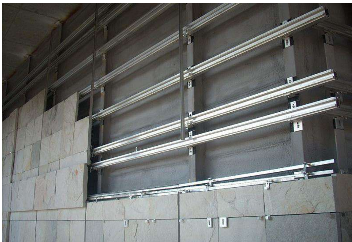
Figura 4.1. Instalación de fachada trasventilada de piedra en la Ciudad de la Cultura en Santiago de Compostela, Galicia. Cedida por CTG.
