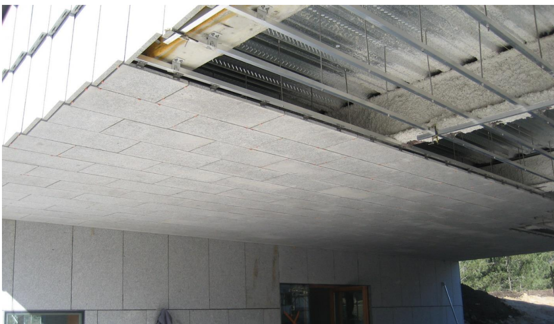
Figura 5.57 (arriba). Edificio para la cinemateca francesa en Paris (Frank Gehry, 1996). Fotografía de la autora. Figura 5.58 (abajo). Instalación de falso techo de piedra en el Centro de interpretación de Arte Rupestre, Pontevedra. (RVR arquitectos. 2009). Fotografía cedida por el estudio de arquitectura.
