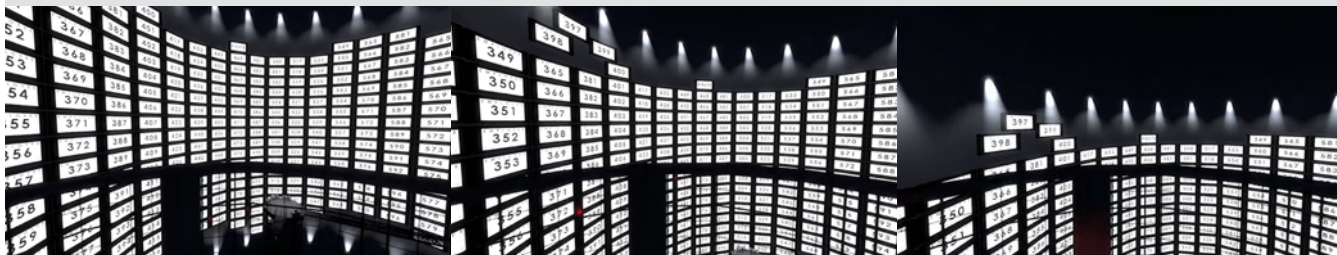
Sec.1.1'.4. Secuencia Sala de Control.
