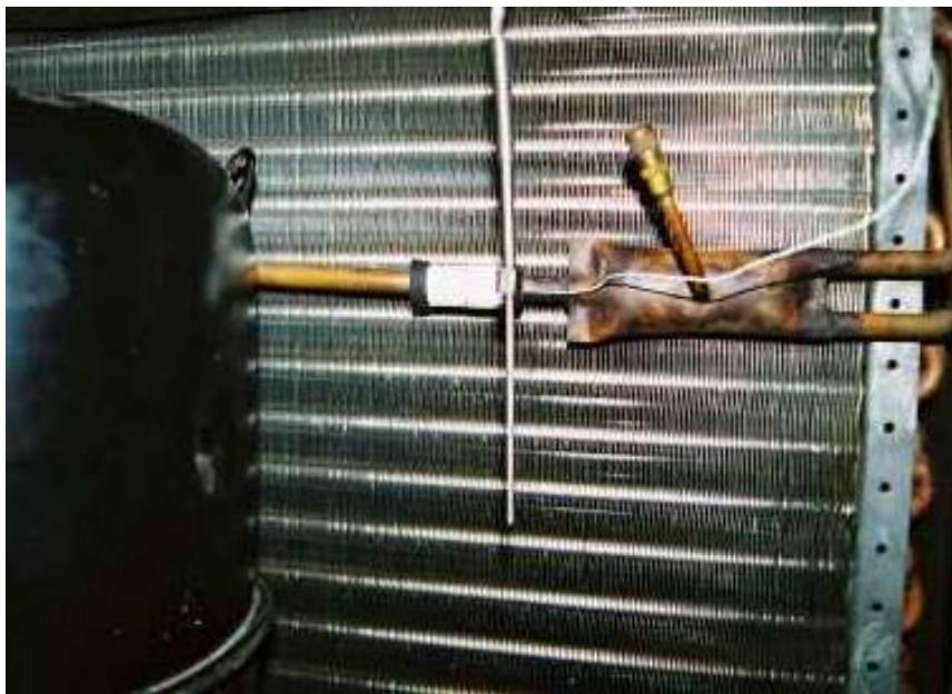
Figura 2.38 Batería condensadora de tubos aleteados para convección forzada
