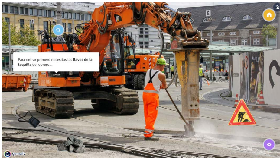
Ilustración 2.57. Información adicional proporcionada al pulsar sobre la excavadora (zona de obras).
