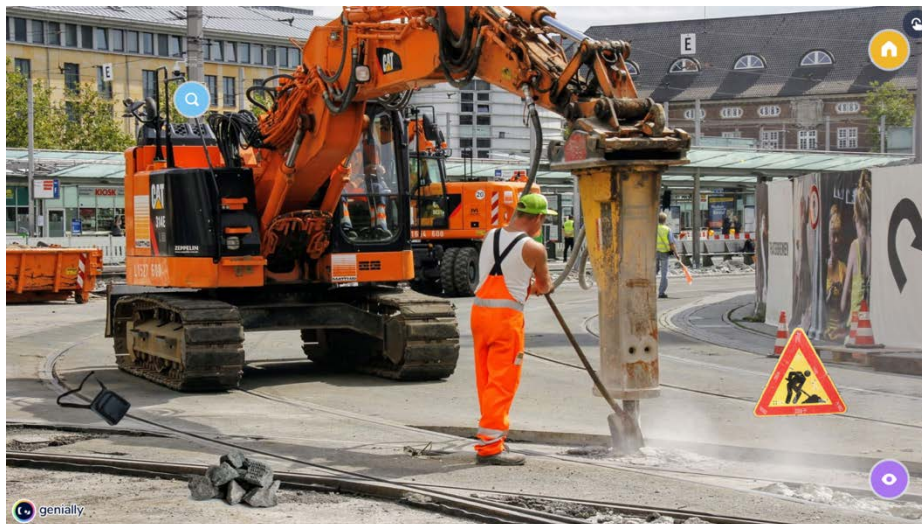
Ilustración 2.53. Escenario inicial de la zona de obras.
