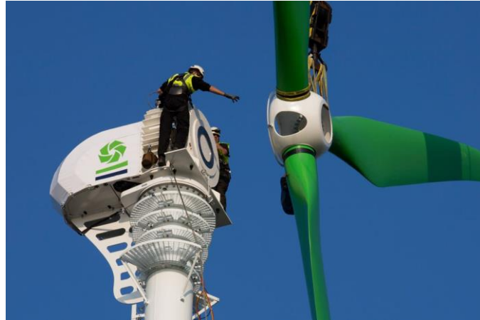
Figura 5.26: Imagen tomada de la construcción de un aerogenerador M-26.
