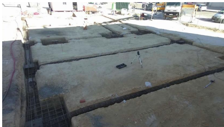
Figura 17. Cimentación de nave industrial. [11]
