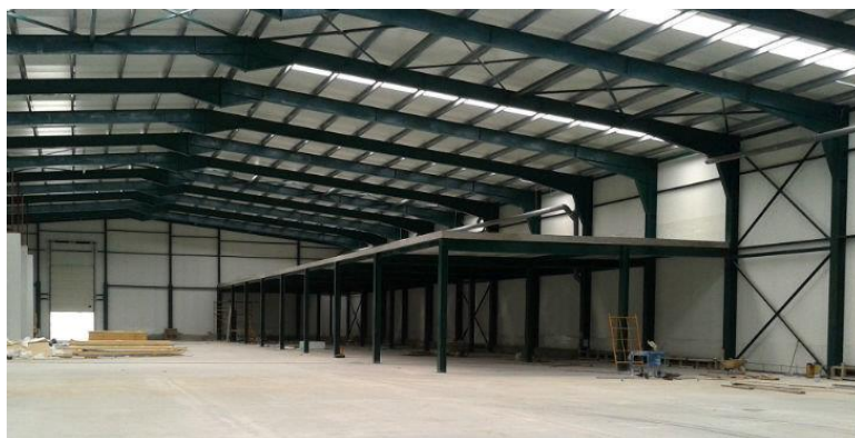
Figura 13. Ejemplo de forjado. [7]
