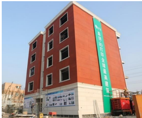
Ilustración 3: Edificio impreso en 3D. Fuente: (Winsun3d, 2015)
