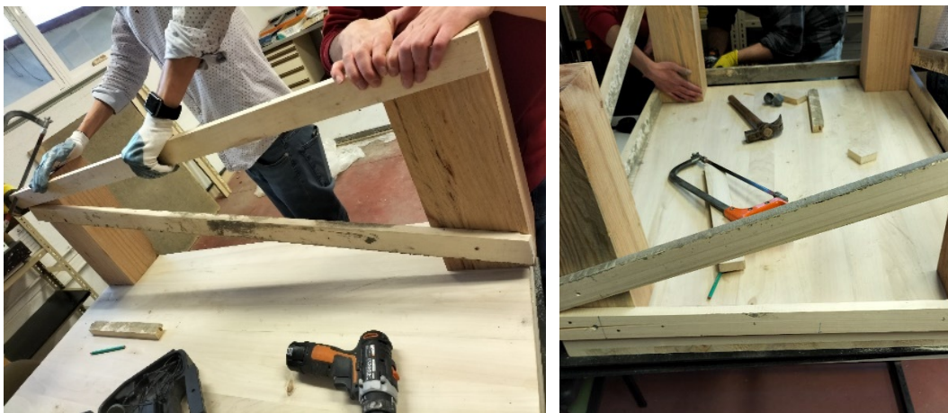
Fig. 40 Proceso de construcción de la estructura soporte.
