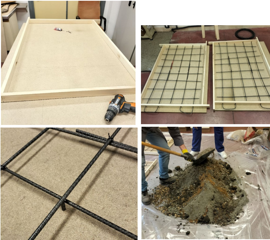
Fig. 36 Preparación del encofrado para elaborar la placa de hormigón (izquierda superior), encofrado listo para verter el hormigón fresco (derecha superior), detalle del montaje de la construcción de la malla de acero (izquierda inferior), y elaboración de la mezcla (derecha inferior).
