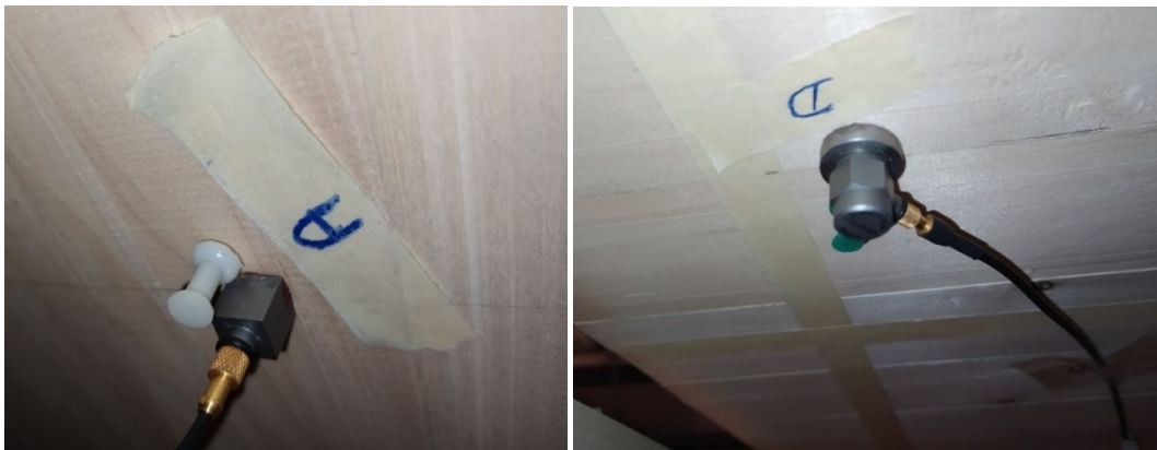
Fig. 43 Detalle de la instalación de los acelerómetros A y D.
